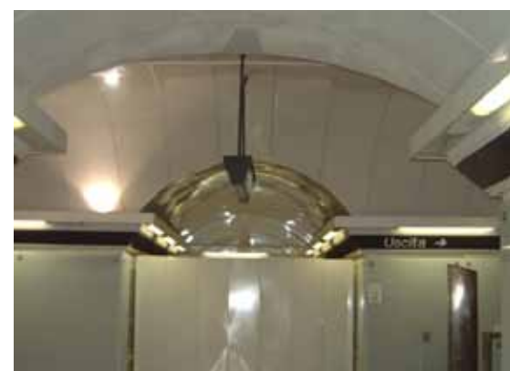
Foto 1. Particolare delle controsoffittature voltate
