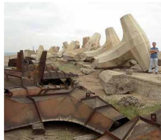
140 dolos prefabbricati in calcestruzzo, del peso complessivo di 16.000 pound e forma simile ai "jacks for giants" saranno utilizzati nello stato di Washington per mitigare l'erosione lungo le sponde del fiume Puyallup. ...
