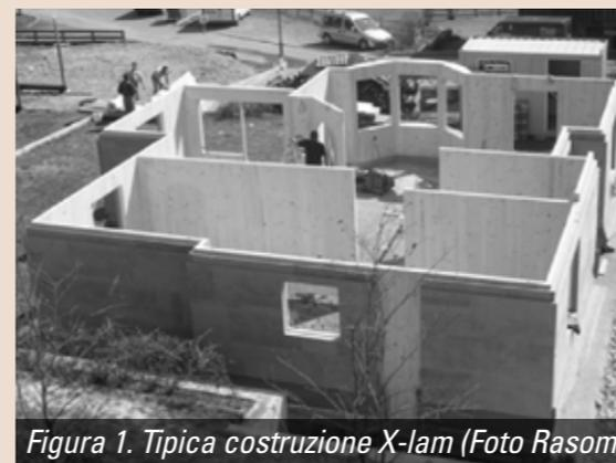
Figura 1. Tipica costruzione X-lam (Foto Rasom)
