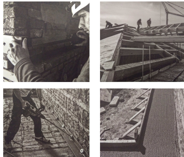
Figure 1 - 4: Lavorazioni Collaudo per la resistenza delle reti d'acciaio applicate alle murature; ricostruzione del tetto a falde inclinate, avvenuta dopo lo smantellamento della precedente copertura, fortemente danneggiata dal sisma e non recuperabile secondo i criteri di conformità sismica; solidarizzazione tra solai e muri portanti; interventi sulle fondazioni.
