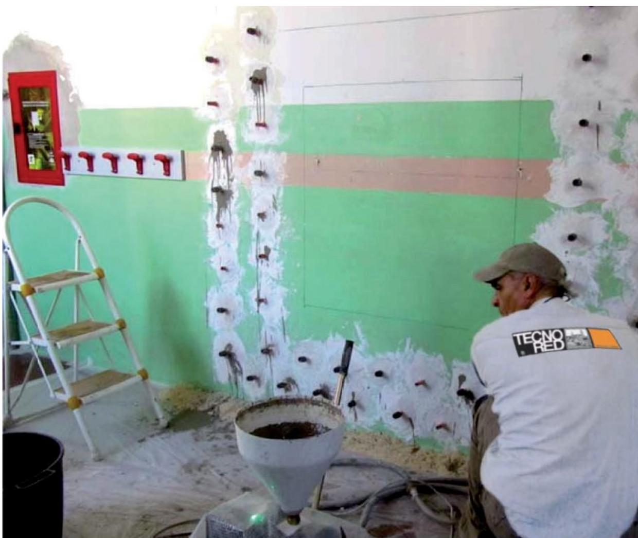
Fig. 01: Preparativi per la prova: Realizzazione di una "vasca di contenimento" per evitare la dispersione della boiaccia "Inetta&Consolida®"
