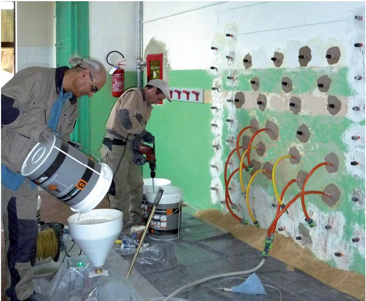
Fig.02: Iniezione della boiaccia consolidante "Inietta&Consolida®". Sono state previste 2 iniezioni a distanza di 24 ore l'una dall'altra per compensarne i ritiri fisiologici.
