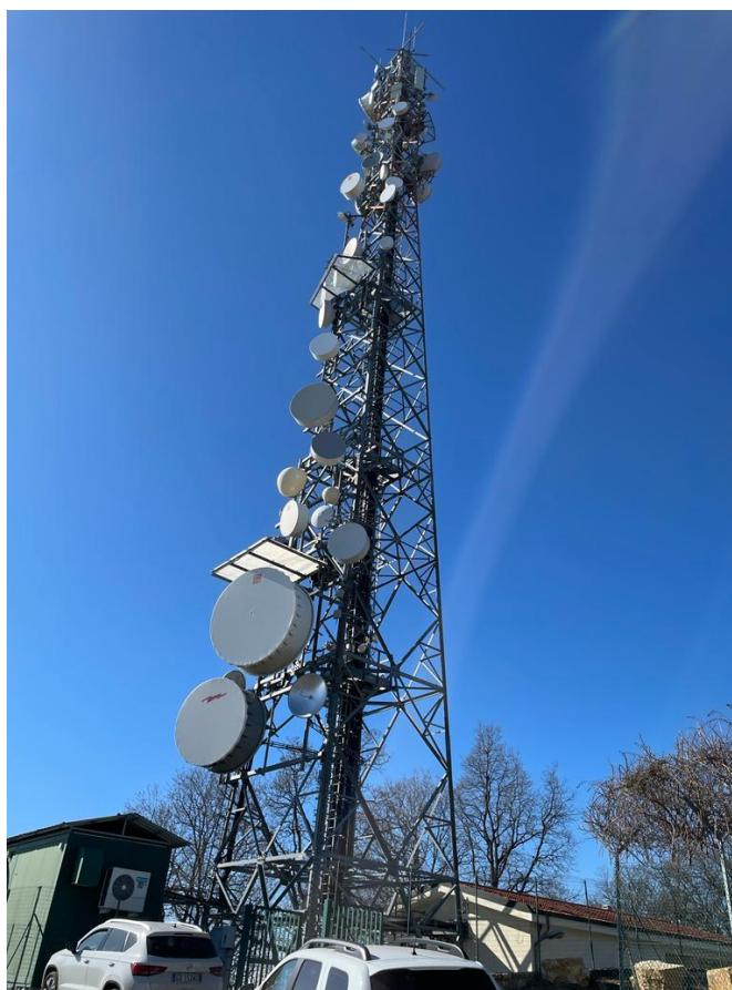
Figura 1 – Torre in acciaio per le telecomunicazioni
