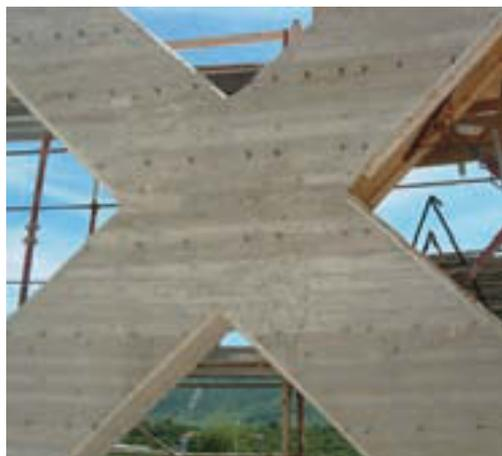
Fig. 3 - Particolare post scassero: getto in classe di consistenza S5.
