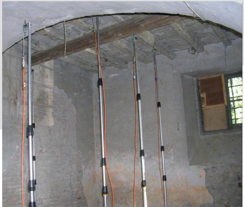
Ubicazione dei sensori all'intradosso del solaio in legno massiccio sottoposto a prova di carico.
