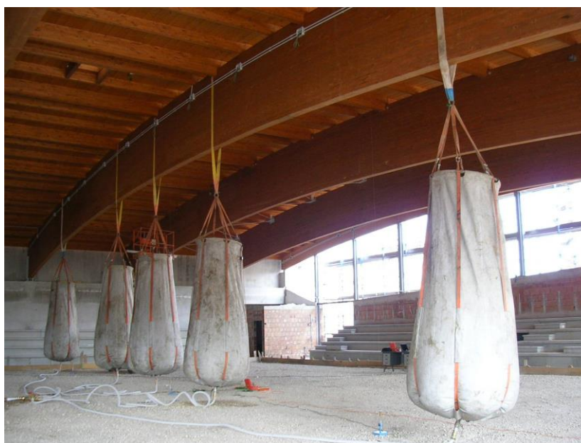
Prova di carico su copertura in legno lamellare
