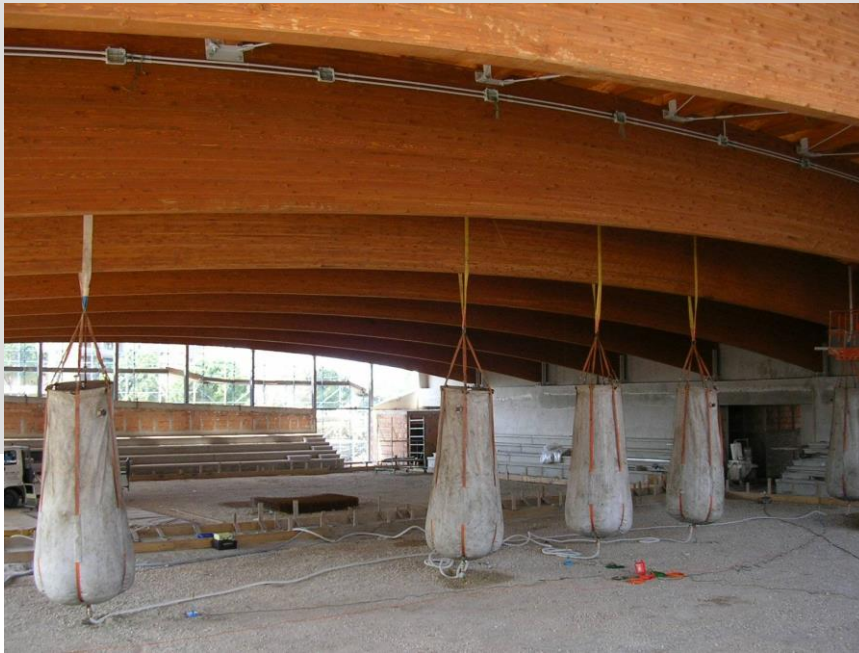
Prova di carico con serbatoi pensili su copertura in legno lamellare
