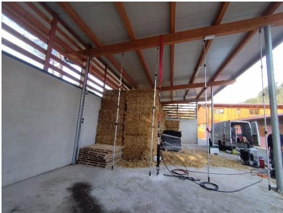
Prova di carico su trave in legno lamellare
