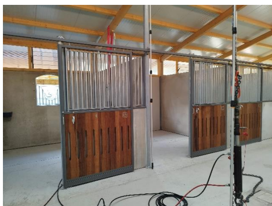
Applicazione del carico e misura degli spostamenti su trave in legno lamellare di una copertura inclinata
