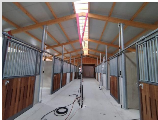
Applicazione del carico e misura degli spostamenti su trave in legno lamellare di una copertura inclinata
