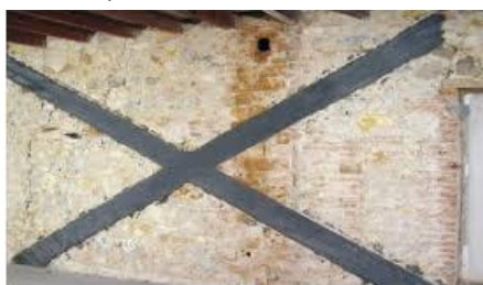
Disposizione FRP per problematiche di taglio in pannelli tozzi
