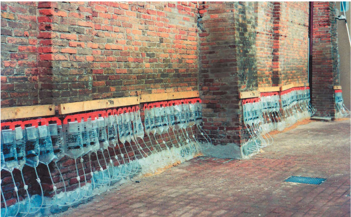
Realizzazione della barriera idrofobizzante previa trasfusione del formulato contenuto nelle sacche graduate sino a completo assorbimento dello stesso. I tempi necessari per questa fase di intervento risultano variabili dalle 36 alle 48 ore.
