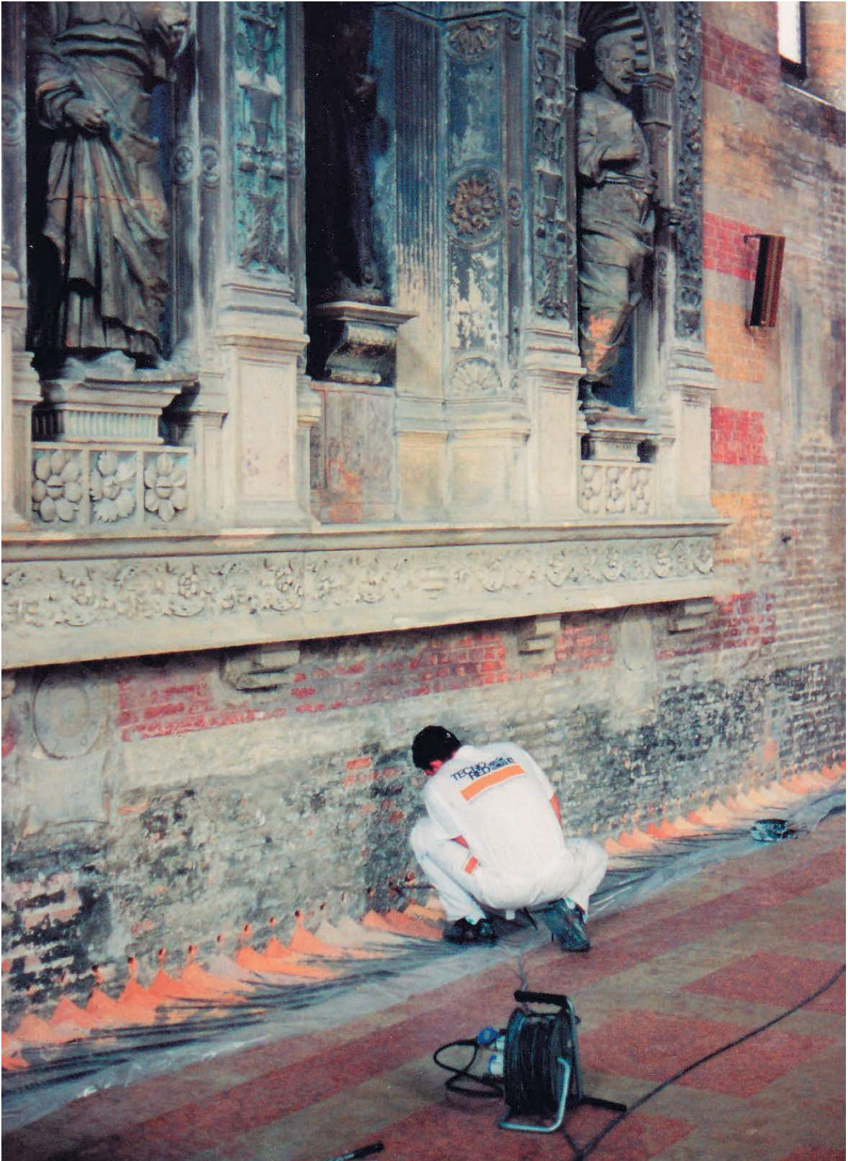
Tomba di Jacopo da Carrara, opera dello scultore veneziano Andriolo de Santi (XIV sec.). Perforazioni per la posa dagli iniettori in cellulosa pressata per la realizzazione della barriera idrofobizzante.
