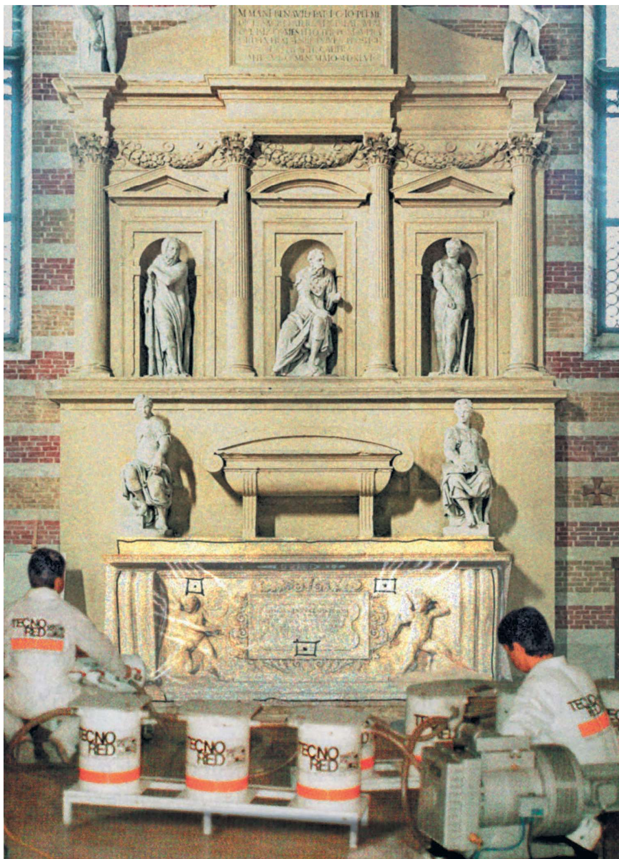
Idrofobizzazione dell'altare del Mantua Benavides con la tecnica del sottovuoto dinamico
