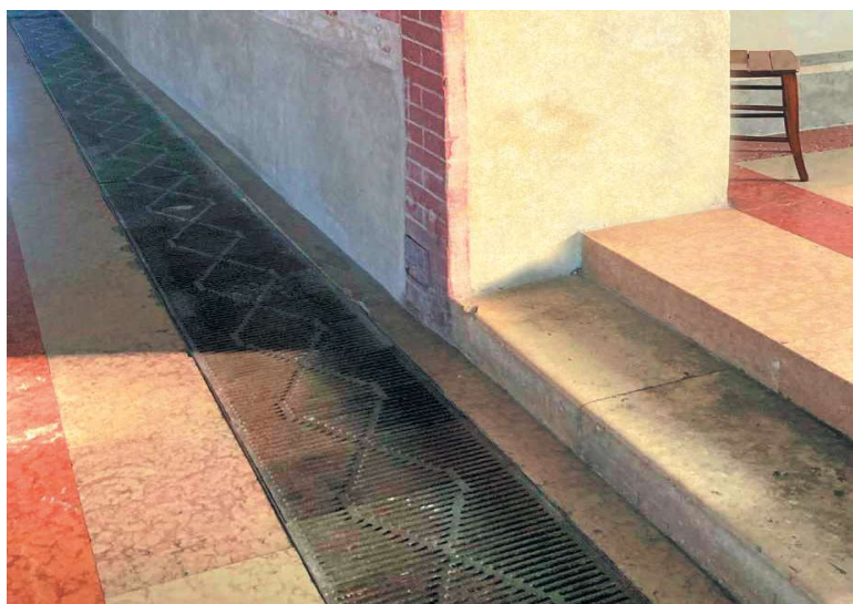
Particolare dell'impianto di riscaldamento ad aria calda che corre lungo tutto il perimetro interno della Chiesa: da modificare
