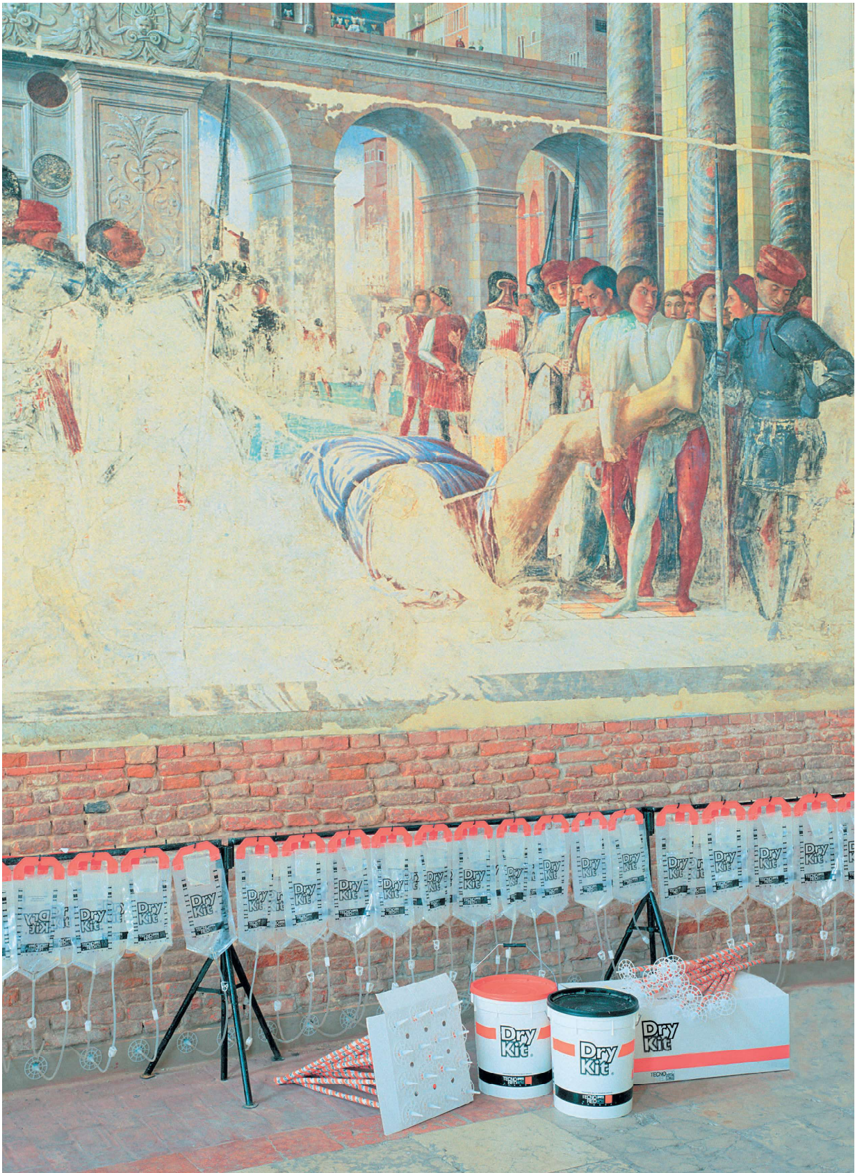
Martirio e trasporto di San Cristoforo, affresco di Andrea Mantegna. Fasi di intervento per la realizzazione della barriera idrofobizzante con formulato specifico TRF 135.
