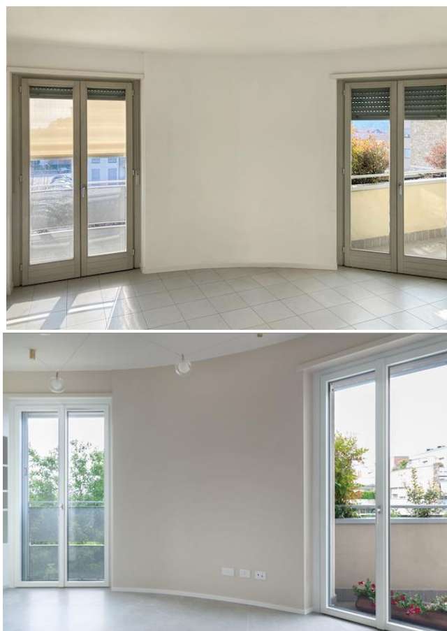
Fig. 1 – Prima e dopo la ristrutturazione
