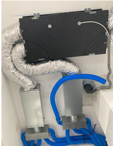
Fig. 4 – Unità di VMC, silenziatori e distribuzione
