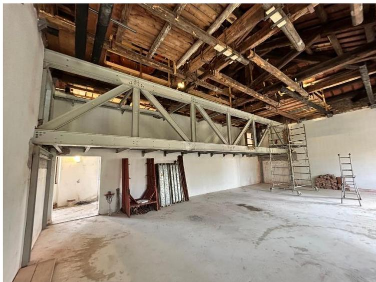
Fig. 2 Passerella in PRFV per edificio storico nel centro di Padova
