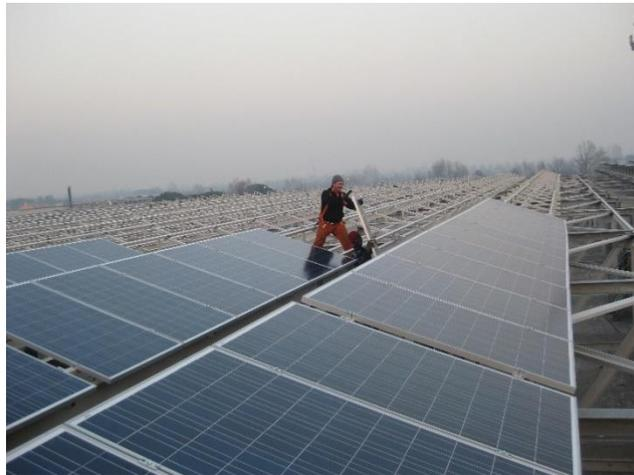
Fig.6 Strutture in PRFV a supporto dei pannelli fotovoltaici
