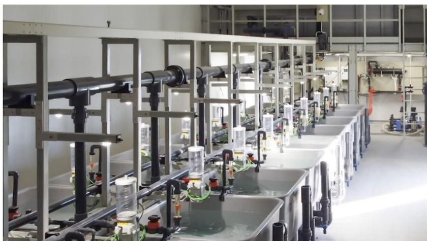
Fig. 5 Passerelle di manutenzione e profili in PRFV per le vasche
