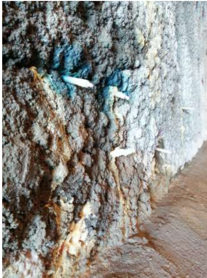
Figura 6 – Iniezioni di consolidamento mediante resine espandenti.
