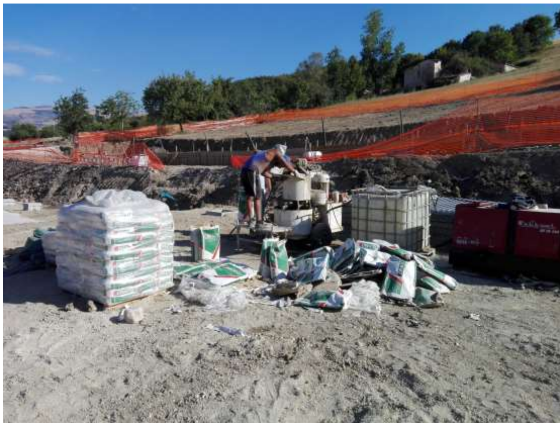
Figura 4 – Preparazione della miscela cementizia mediante FLUECO 77 cable.
