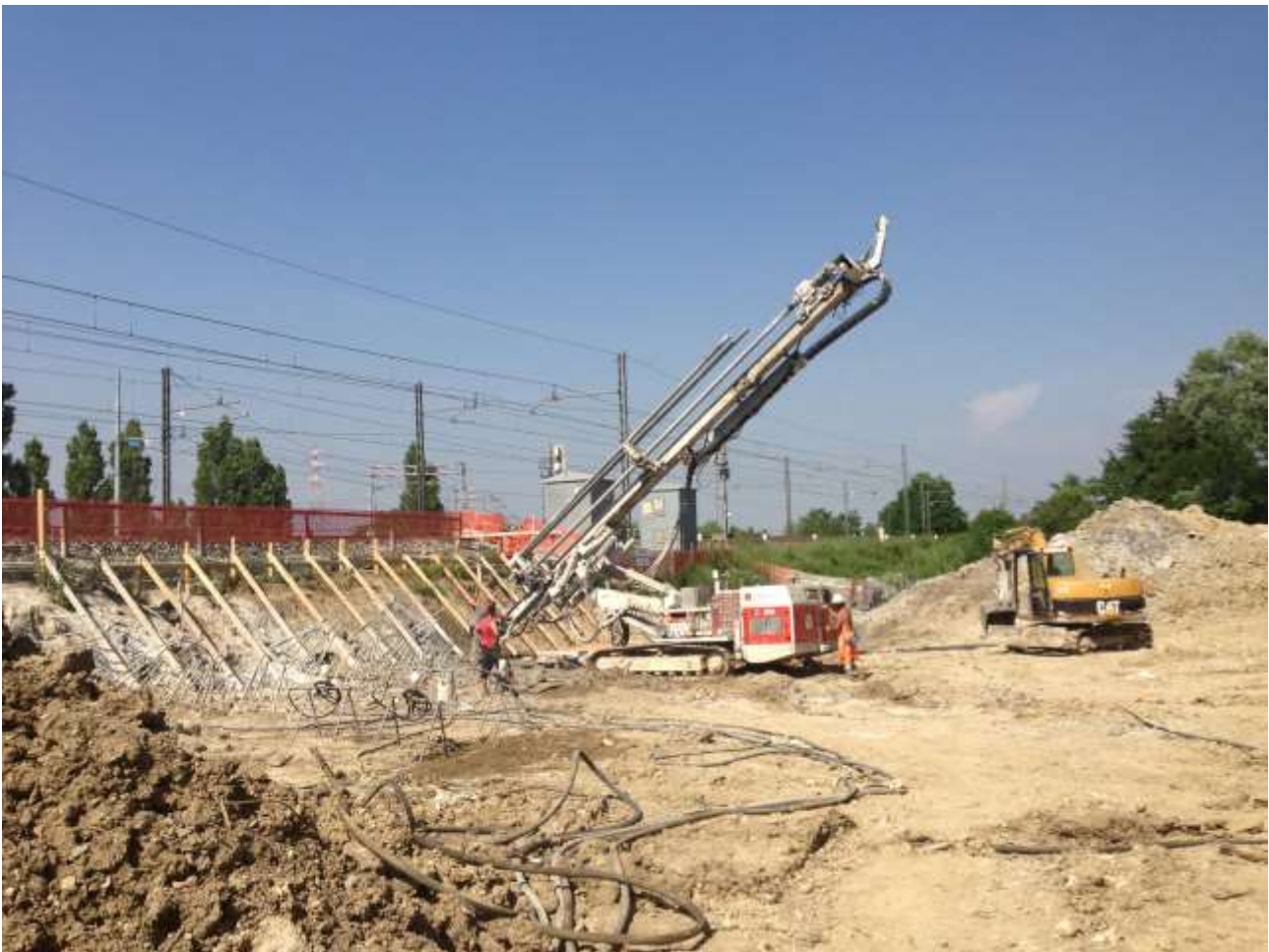
Figura 5 – Consolidamento e stabilizzazione dei pendii mediante iniezioni chimiche con DRACOSOIL.
