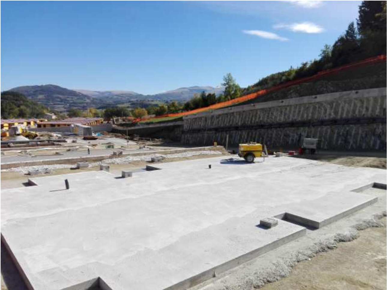
Figura 1 – Consolidamento dei terreni mediante Jet Grouting.
