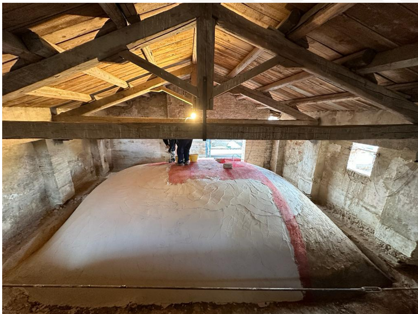
Rinforzo volte in muratura con FRCM – Castello Maresa di Serracapriola
