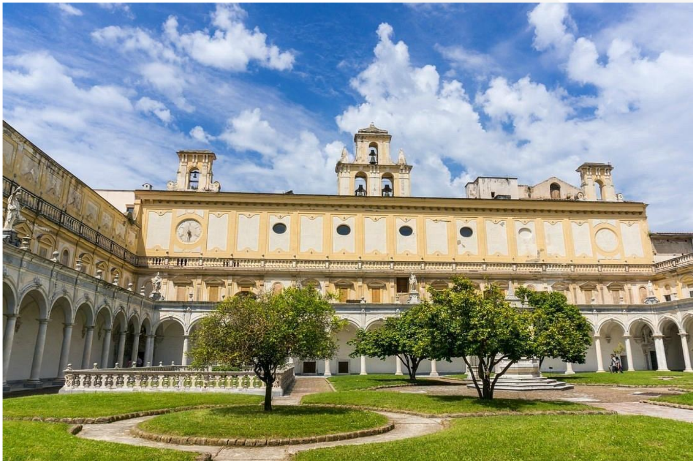
Vela campanaria della Certosa di San Martino consolidata con sistemi OLYMPUS®
