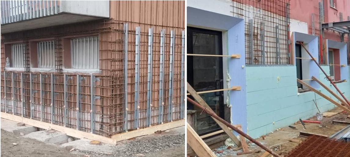
*Disposizione degli Steel Frame, armature e dei pannelli isolanti, prima del getto di betoncino, [sismacoat.it](http://sismacoat.it)*
