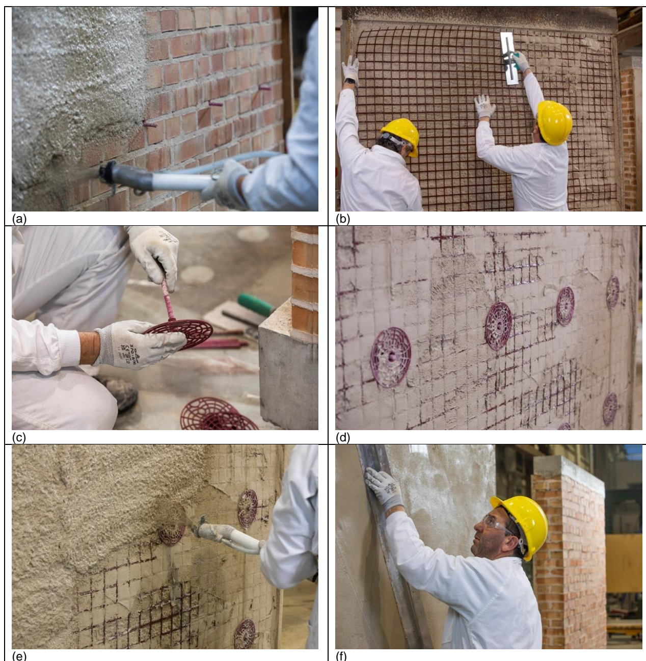
Figura 2. Fasi applicative del sistema CRM RESTAURO con sistema di connessione ARMIS ALL-IN-ONE: a) Applicazione primo strato di malta strutturale FORTE CALCE M10; b) Posa della rete ARMIS VETROAR 50×50; c) Pre-assemblaggio dei connettori ARMIS ALL-IN-ONE d) Connettori posati sulla parete; e) Applicazione secondo strato di malta strutturale FORTE CALCE M10; f) Staggiatura delle superfici.
