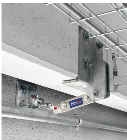
Esempio di installazione dei dispositivi SismoShock
