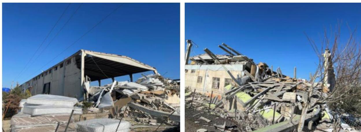
Fig. 3 Crollo di edificio prefabbricato in c.a. in presenza di collegamenti tra elementi strutturali (Terremoto in Turchia - febbraio 2023)<sup>1</sup>
