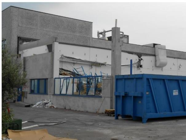
Fig.1 Collasso della copertura di struttura prefabbricata per perdita d'appoggio (Mirandola 2012)
