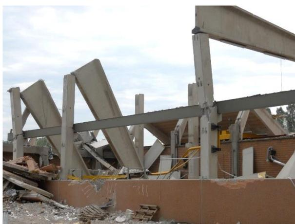
Fig. 2 Crollo di edificio prefabbricato in c.a. in presenza di collegamenti tra elementi strutturali (Terremoto in Emilia maggio 2012)
