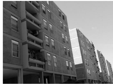
Costruzioni miste in muratura e conglomerato cementizio armato, anni '70-'80, fotografie SismaCoat
