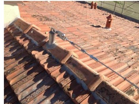
Dispositivo di ancoraggio TIPO C
