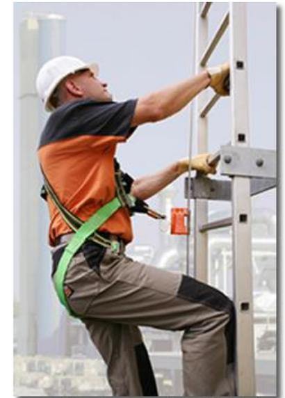
scala a due montanti dotata di dispositivo guidato flessibile UNI 353.2
