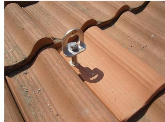
Dispositivo di ancoraggio TIPO A
