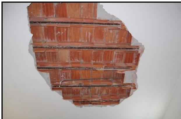
Questi danneggiamenti, oltre ad essere causa di una riduzione complessiva della resistenza meccanica del blocco, possono anche costituire i punti di innesco di lesioni che, progredendo nel tempo per via dello stato tensionale esistente, isolano porzioni di laterizio man mano più estese, fino a determinarne la completa separazione e la caduta.
