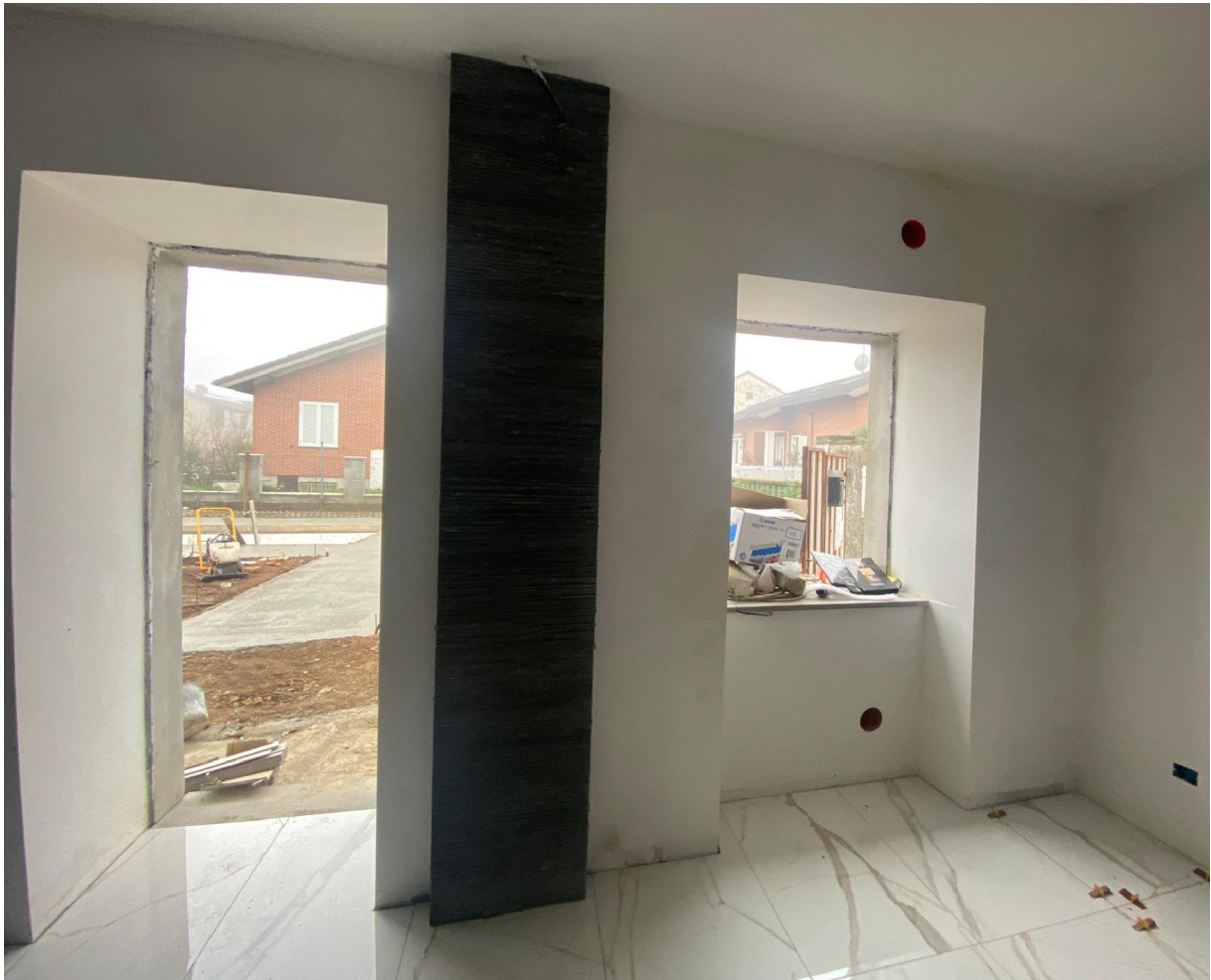
Finiture finali all'interno dell'edificio
