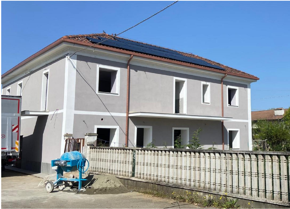
Prospetto sud-ovest dell'edificio lato strada dopo l'intervento.
