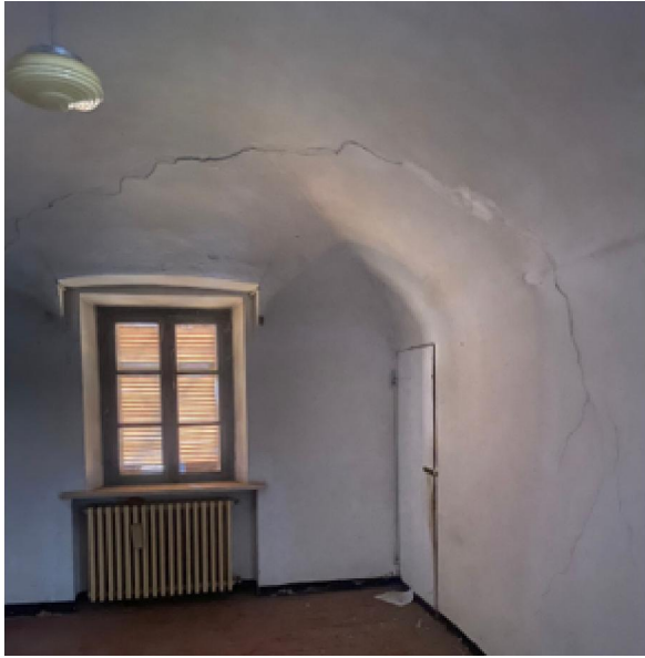
Fessura sub-orizzontale sulla volta e fessure sub-verticale sulle pareti.
