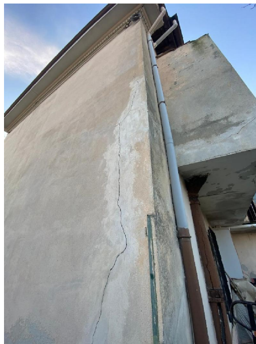
Lesioni lungo le facciate esterne dell'edificio.
