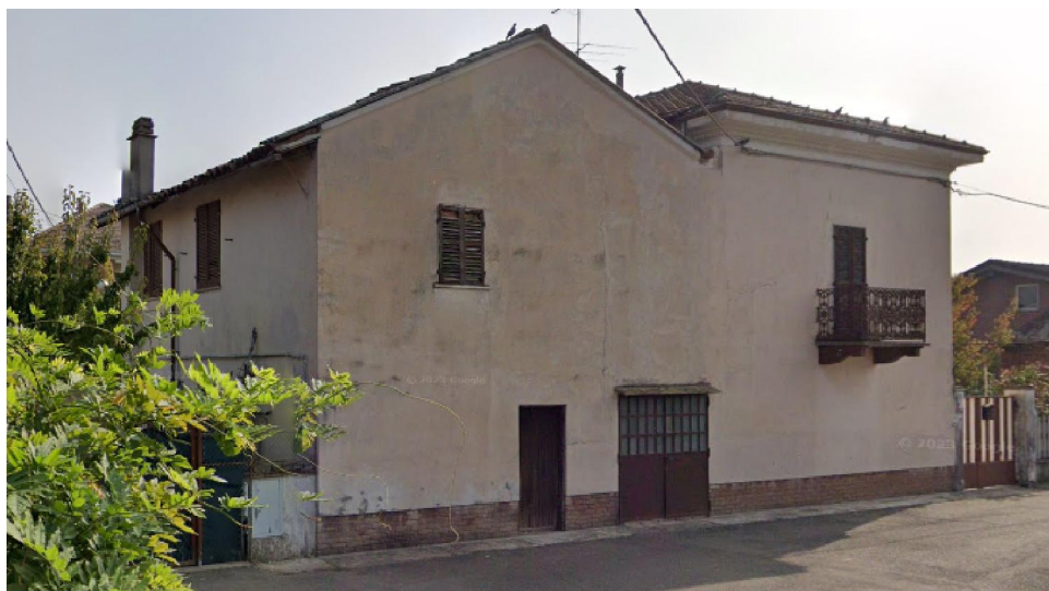
Prospetto nord-ovest dell'edificio lato strada.
