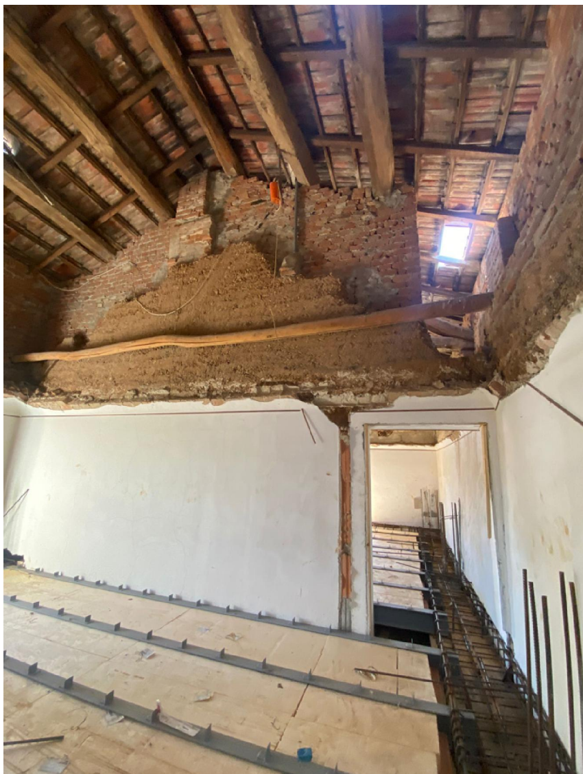
Realizzazione dei connettori dei solai e delle travi di piano
