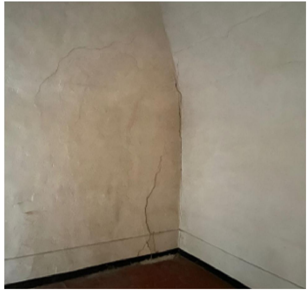
Fessura sub-orizzontale sulla volta e fessure sub-verticale sulle pareti.
