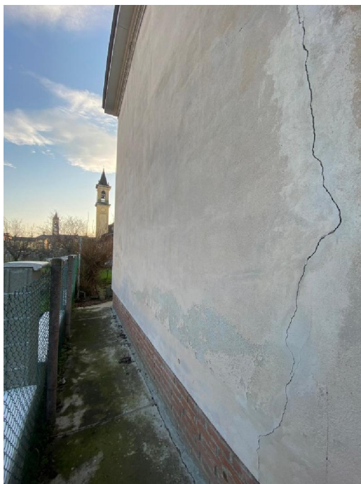
Lesioni lungo le facciate esterne dell'edificio.
