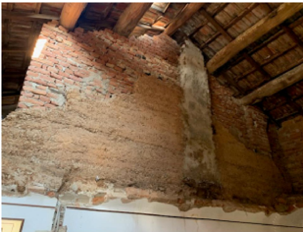
Pareti del timpano realizzate in parte in terra cruda.
