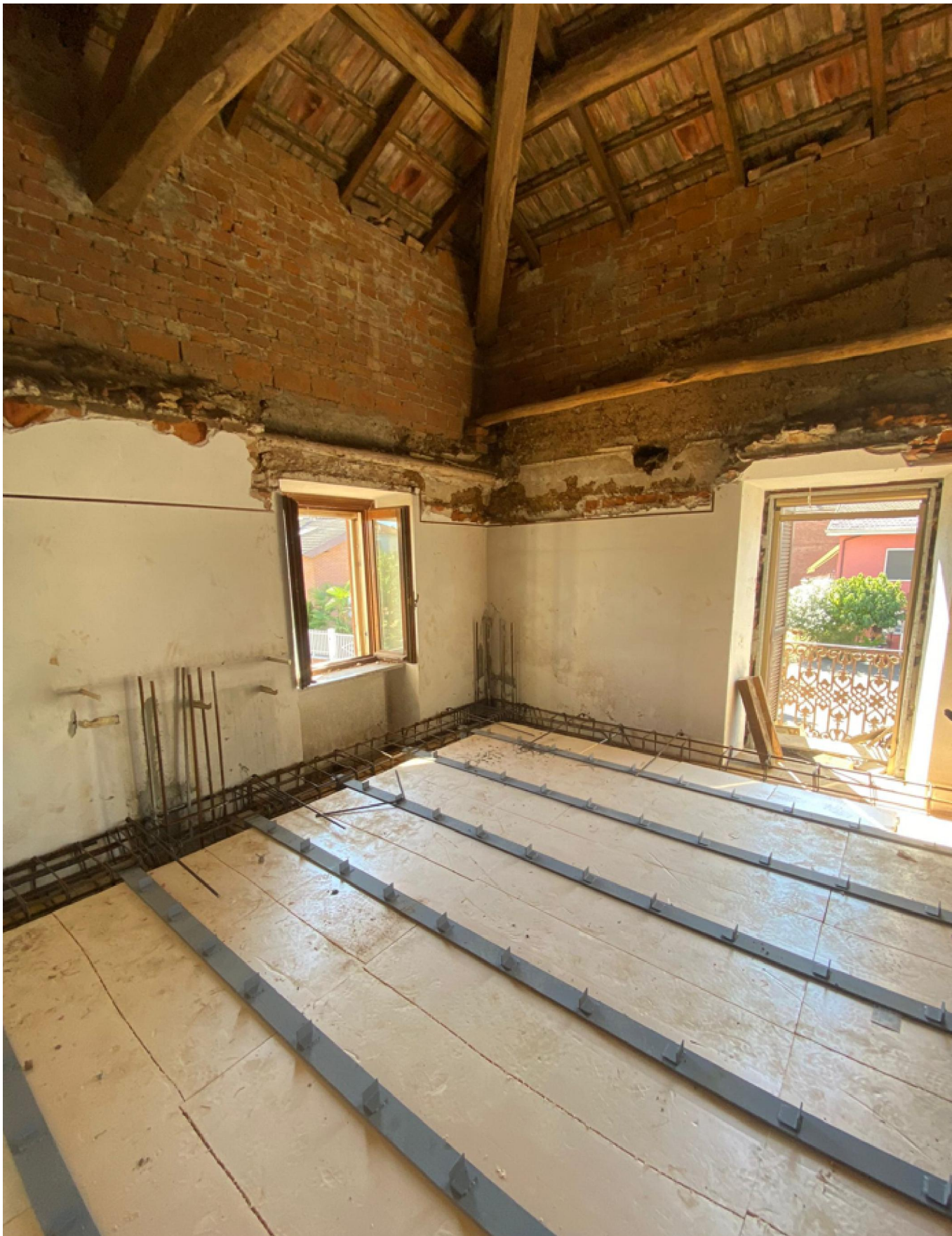
Realizzazione dei connettori dei solai e delle travi di piano
