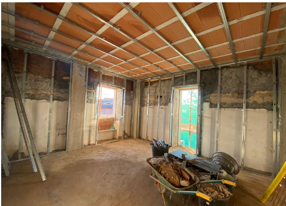
Nuova struttura portante in c.a. e nuovi solai misti in acciaio e tavelloni.
