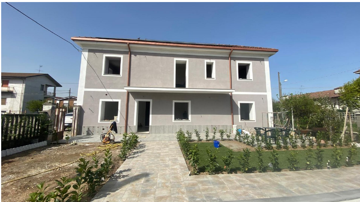
Facciata principale dell'edificio dopo l'intervento
