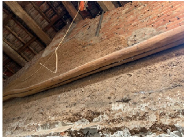
Pareti del timpano realizzate in parte in terra cruda.
