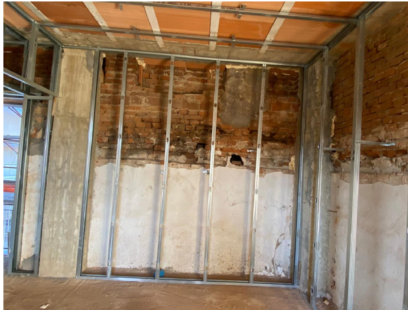
Nuova struttura portante in c.a. affiancata alla muratura esistente
