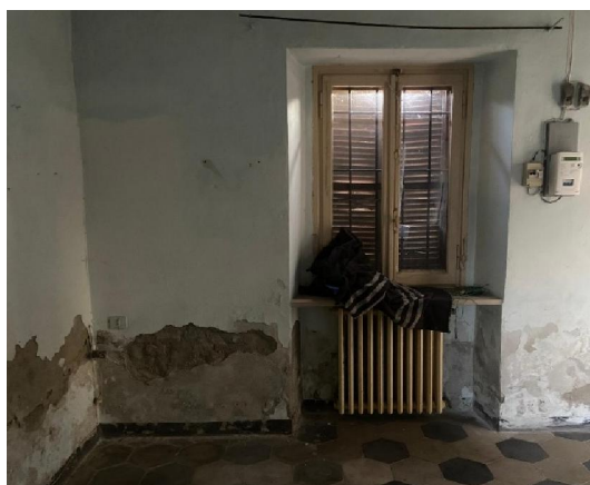
Segni degrado lungo le pareti e i soffitti dell'edificio.
