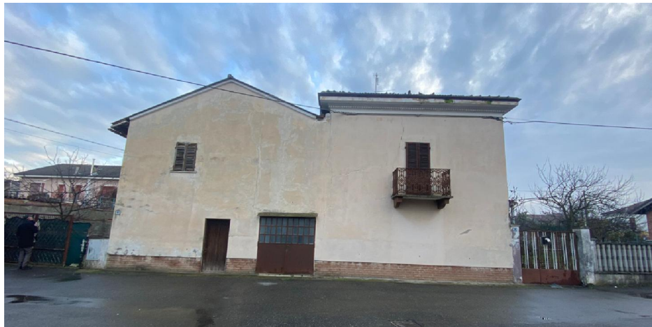
Prospetto ovest dell'edificio lato strada.
