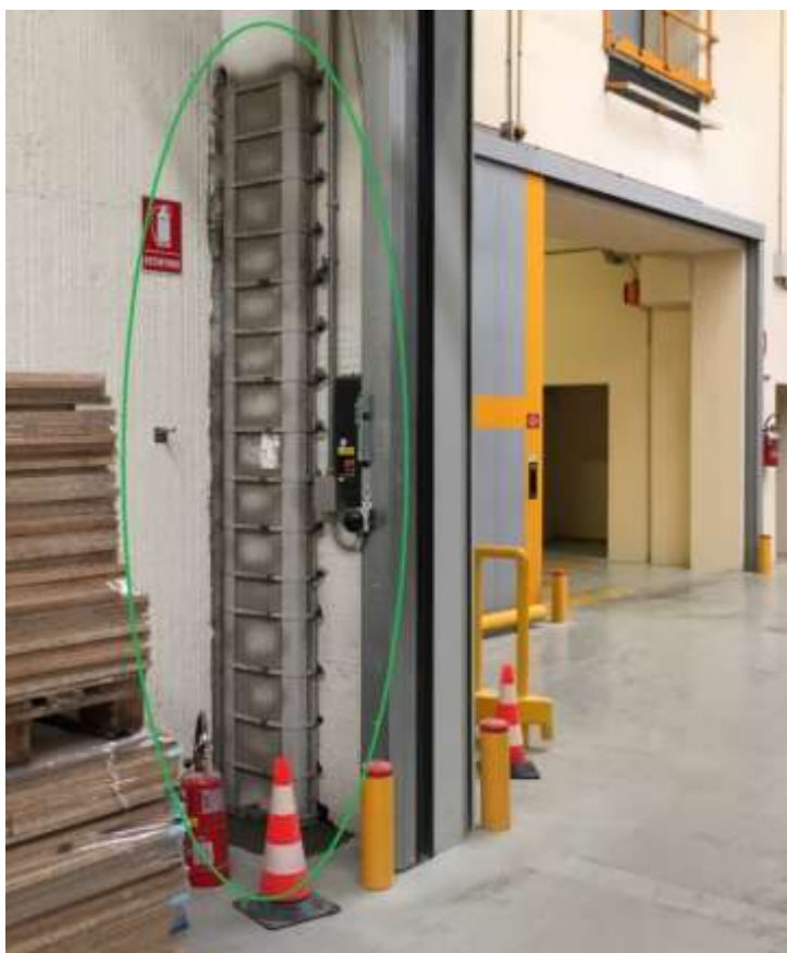
Miglioramento sismico di un'importante multinazionale alimentare nel Bresciano
