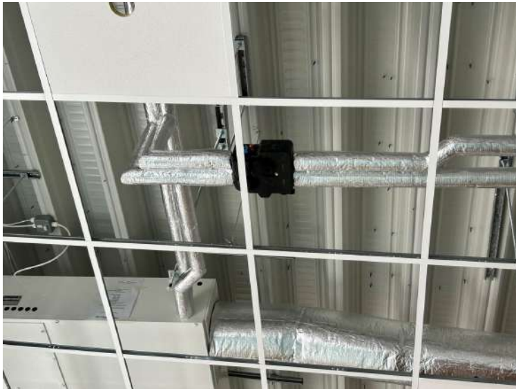
Fig.7 – Installazione in controsoffitto del kit fan coil R280KC
