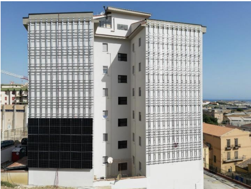
La struttura di fissaggio per la facciata fotovoltaica realizzata con i prodotti fischer
