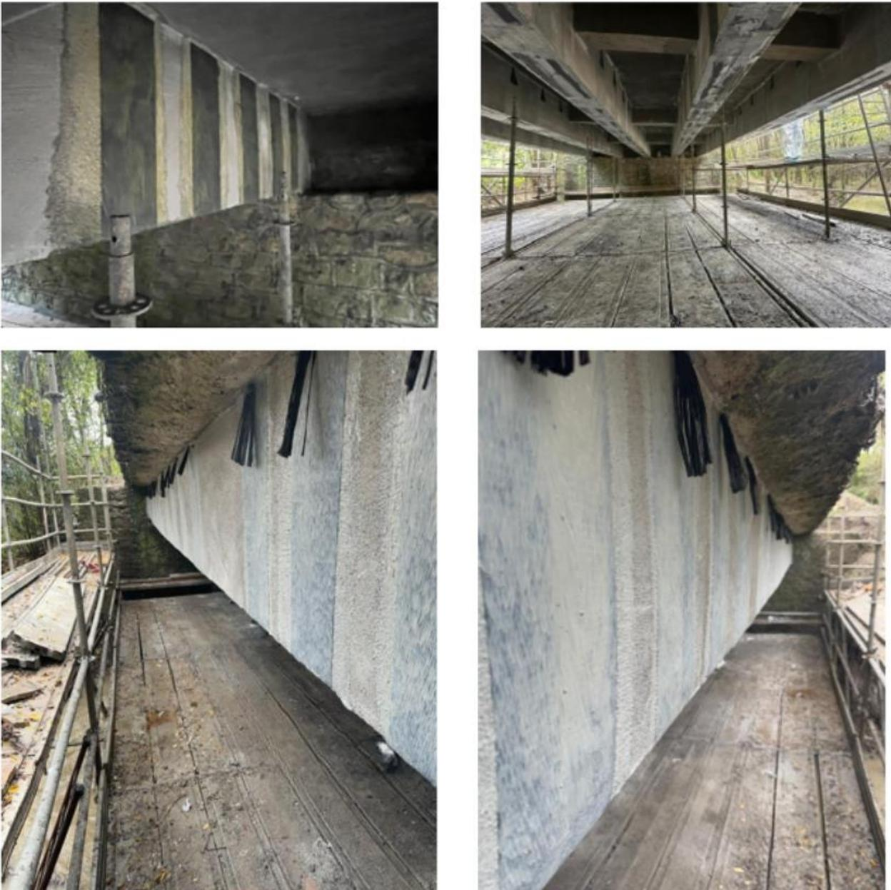
Fig. 9 Applicazione di sistemi FRP della Linea Betontex di Fibre Net
