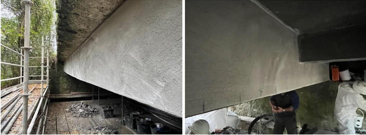
Fig. 8 Ricostruzione delle zone ammalorate mediante applicazione a mano di specifiche malte cementizie aventi classe R4 secondo la normativa UNI EN 1504
