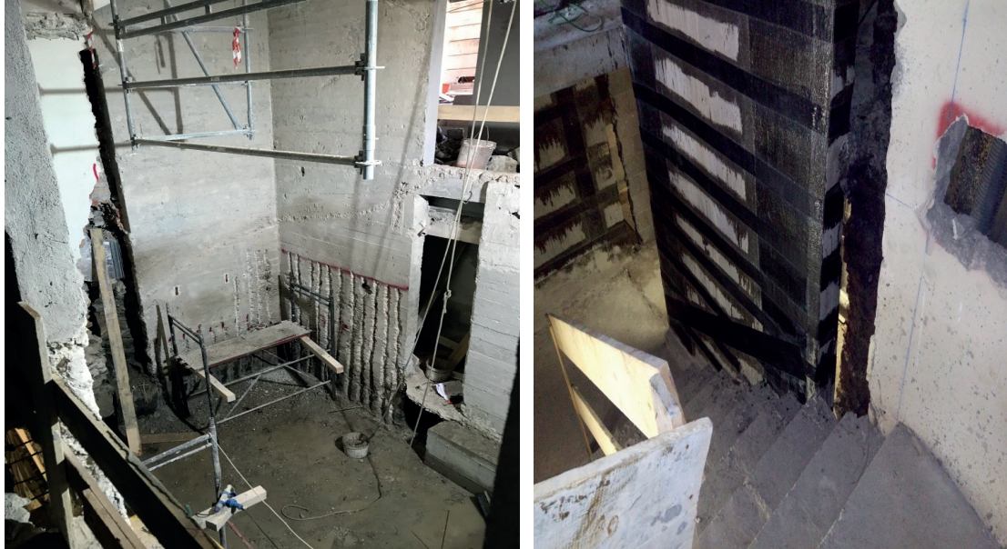
Realizzazione di un collegamento efficace in fondazione
