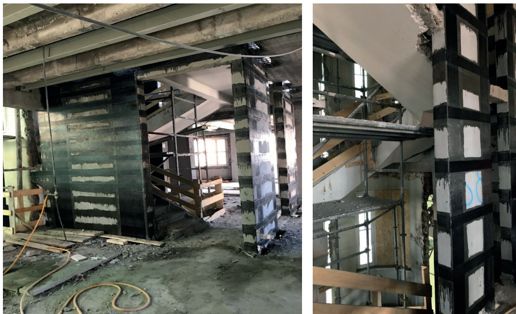
Posizionamento dei rinforzi IN CFRP sui setti esistenti dei vani scala
