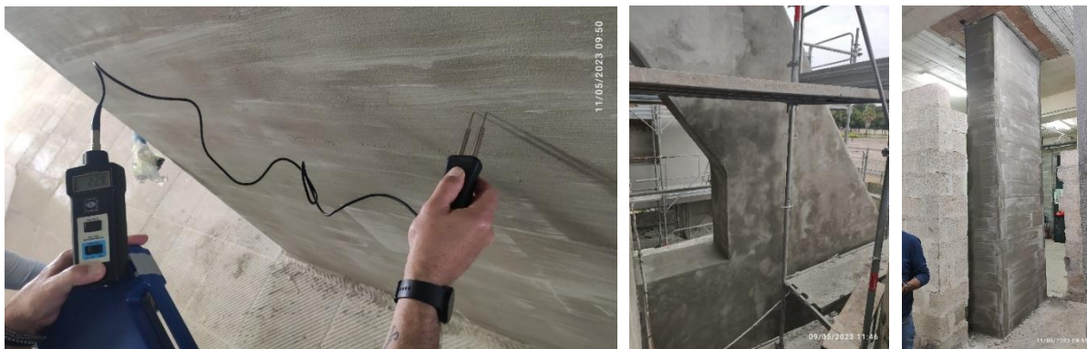
Controllo delle superfici per passaggio alle fasi successive
