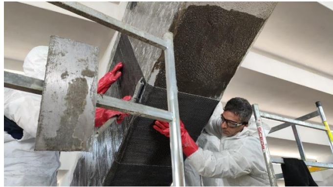
Placcaggio pilastri
