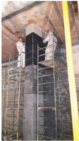
Placcaggio pilastri
