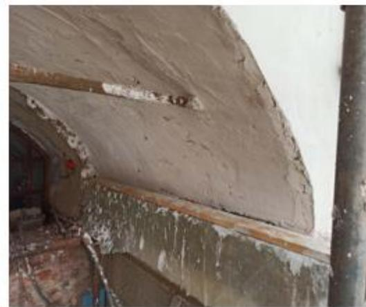
Fig.3 Alcuni dettagli della posa della rete in GFRP del sistema RI-STRUTTURA. Foto @Emilio Prete
