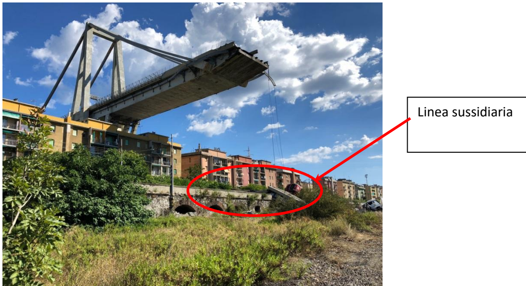
Figura 2 – viadotto sospeso sopra la linea “Sussidiaria
