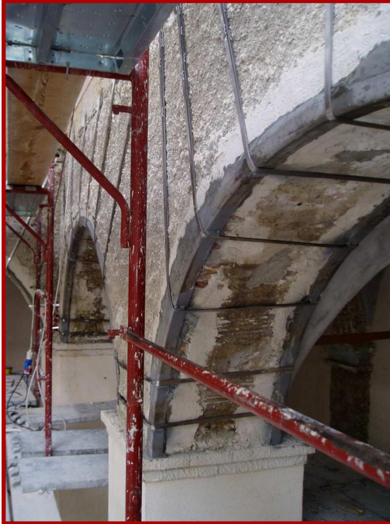
Così come per i maschi murari, alle estremità di ogni foro, sono posizionate, a diretto contatto con il paramento murario, una piastra imbutita e centine angolari in acciaio inossidabile allettati con malta. Le cerchiature incrementano la resistenza allo schiacciamento degli elementi strutturali sottoposti ad eccessiva compressione.
