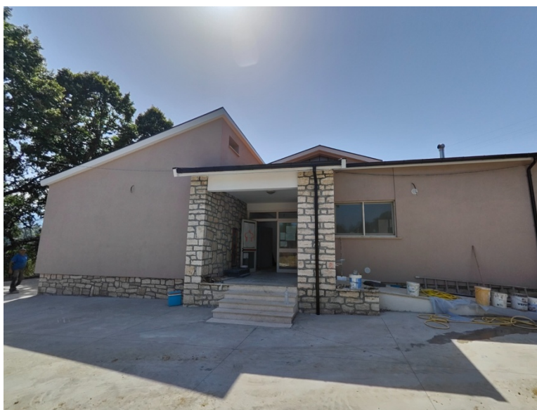
Cantiere della scuola di villa Ripa, a Teramo
