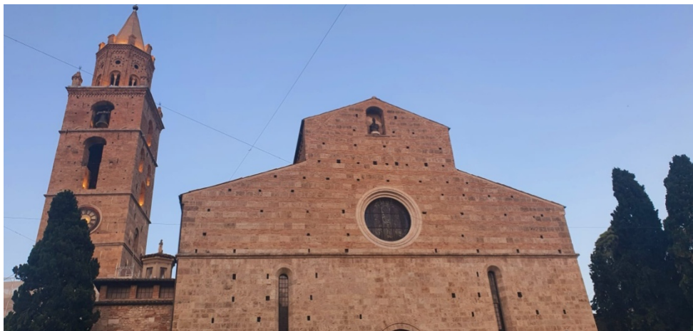
Il Duomo di Teramo restaurato
