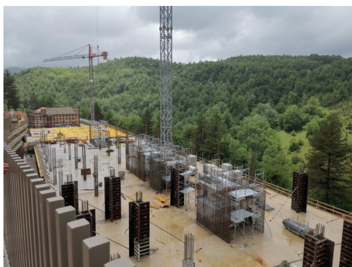
Il cantiere dell'Ospedale Grifoni di Amatrice
