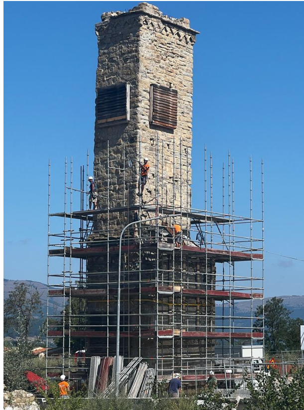
Il cantiere della Torre civica di Amatrice
