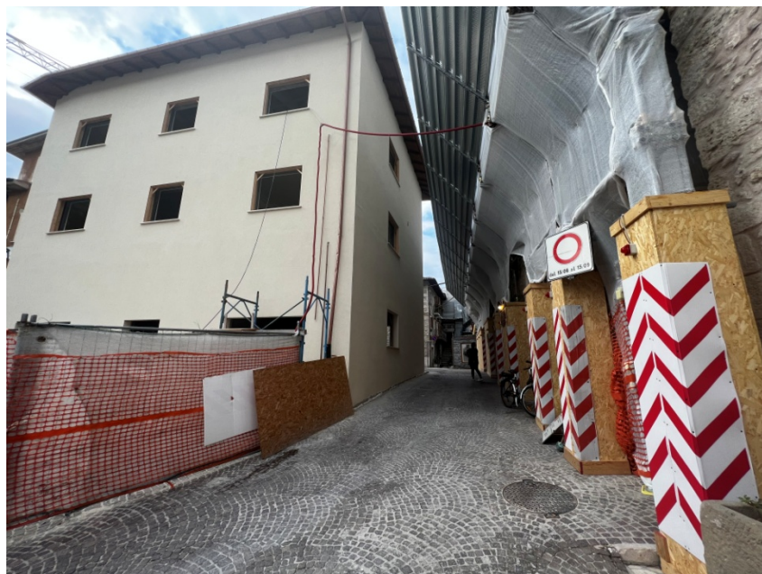
Un cantiere della ricostruzione privata, ad Acquasanta Terme
