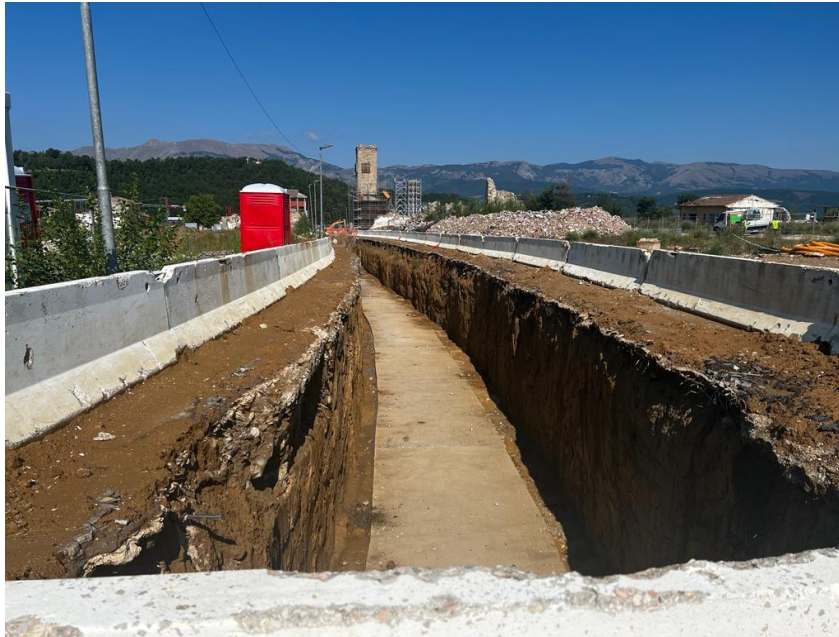
I lavori per il tunnel dei sottoservizi, nel centro storico di Amatrice
