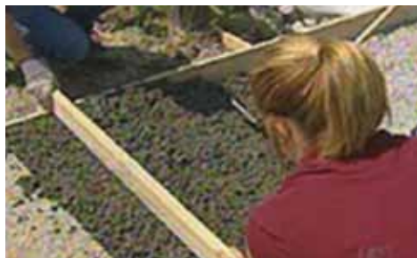
Figura 1. Momento della stesa di calcestruzzo drenante
