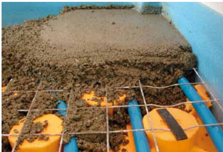
Figura 1. Esempio di massetto con riscaldamento
