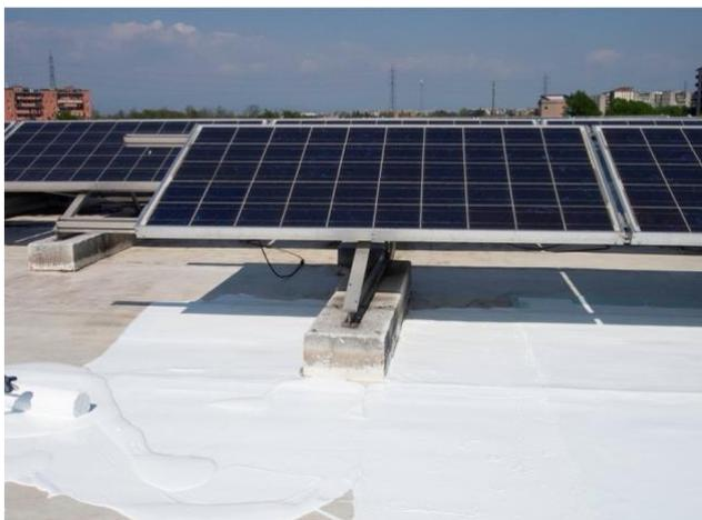
Come già per il Wingum Plus H2O, anche la versione BRoof T2 mantiene tutte le caratteristiche di un impermeabilizzante liquido, elastomerico a base acquosa, a rapida asciugatura che lo rende fuori pioggia dopo solo poche ore, offrendo la possibilità di iniziare e finire il lavoro in giornata. È disponibile in cinque colori.
