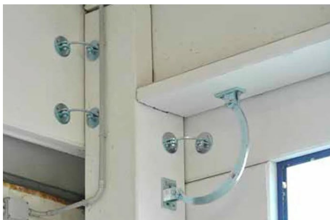
Serie di dissipatori stabilflex posti in opera
