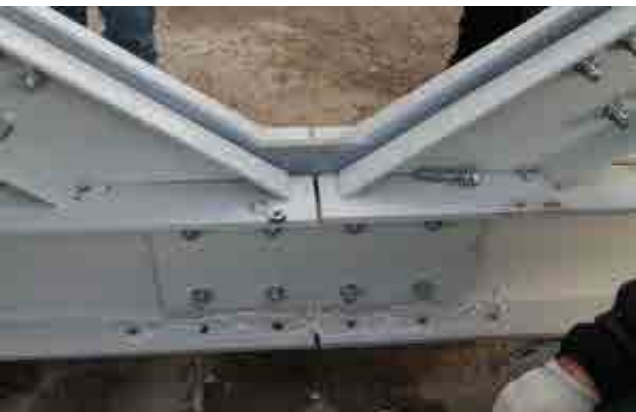
Fasi di assemblaggio delle tre parti di passerella trasportate in situ per il montaggio
