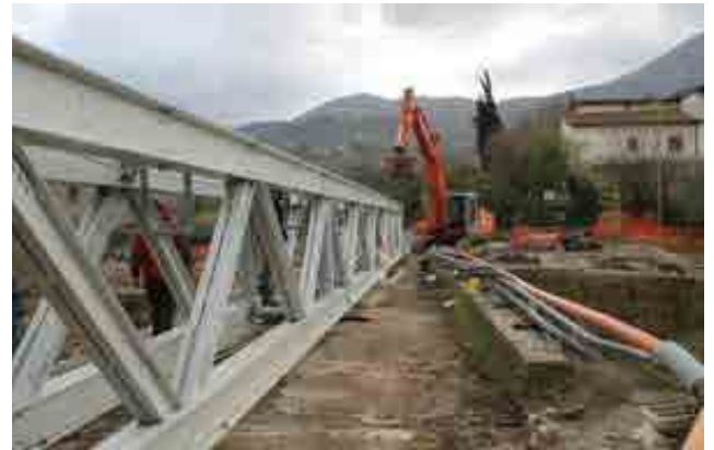
Fasi di assemblaggio delle tre parti di passerella trasportate in situ per il montaggio
