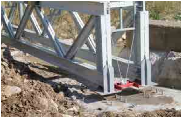
Fissaggio della struttura ai plinti di fondazione
