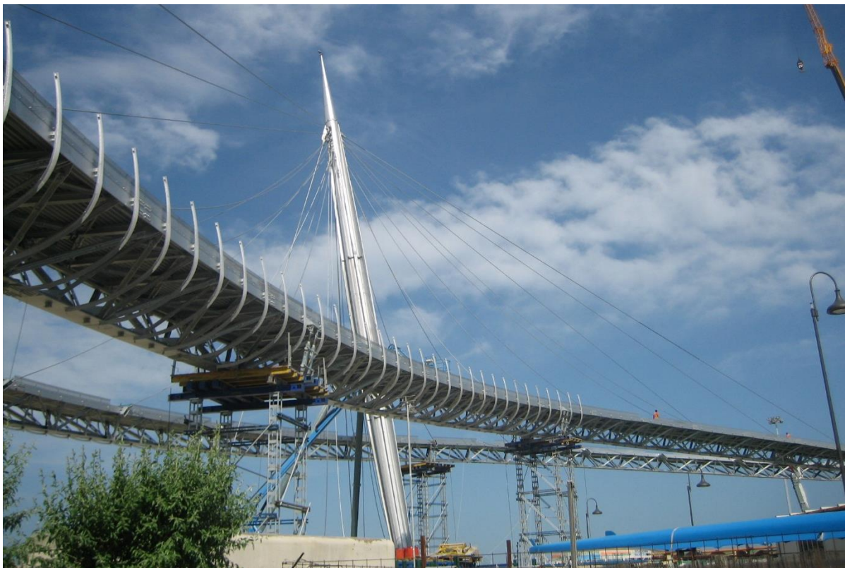
Vista durante una fase di cantiere
