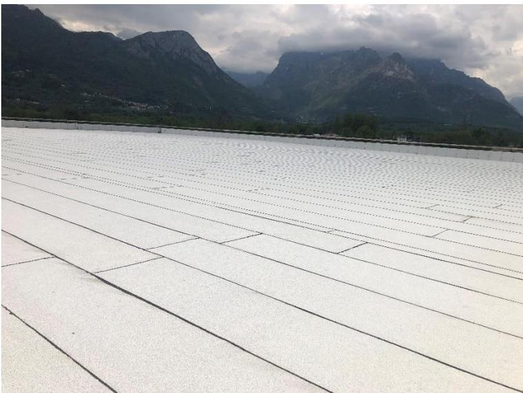
Il valore di resistenza alla grandine è correlato a diversi aspetti dell'elemento di tenuta, in primis sicuramente lo spessore, che deve essere 1,8 mm o 2 mm per i manti sintetici e 4+4 mm per le membrane bituminose; è inoltre di primaria importanza scegliere sistemi con armatura interna ad alta resistenza al punzonamento.
