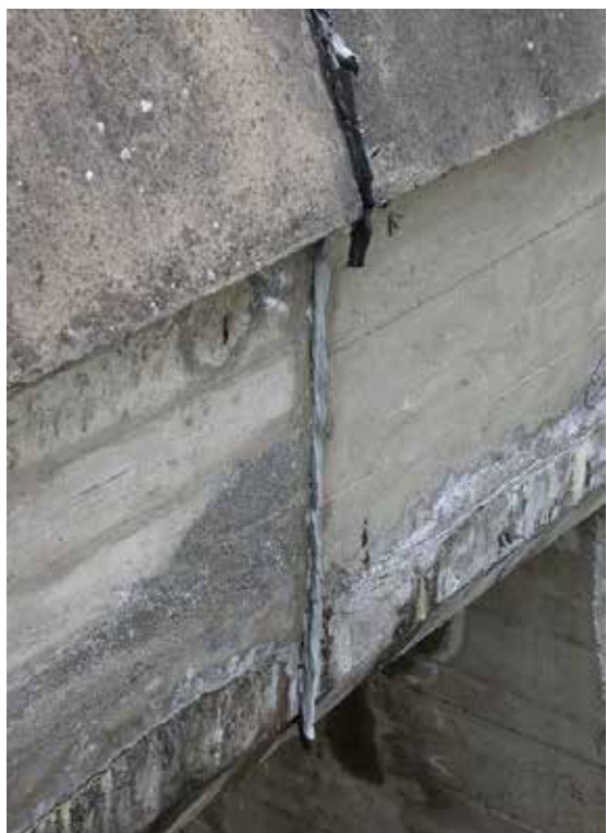
Dettagli interno ed esterno ante-operam
