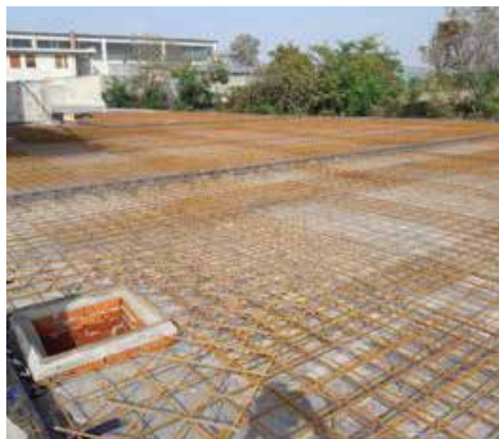
Armatura della pavimentazione esterna Joint-Less
