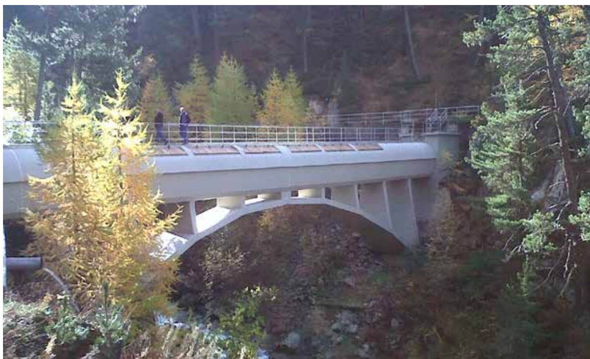
Ponte-Canale Tresenda dopo l'intervento con MasterSeal 6100 FX MASTER BUILDERS SOLUTIONS di BASF
