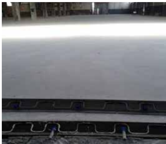
Pavimentazione interna per trattamento superficiale
