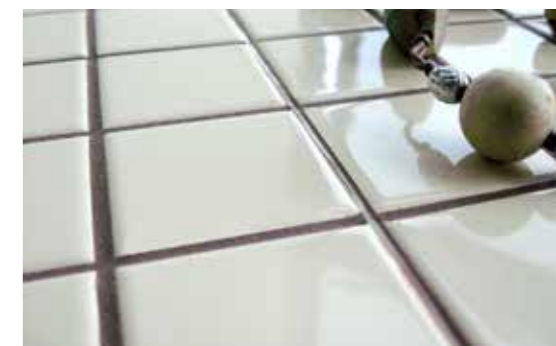
Giunto elastico realizzato in opera con sigillante silconico della stessa colorazione delle fughe.
