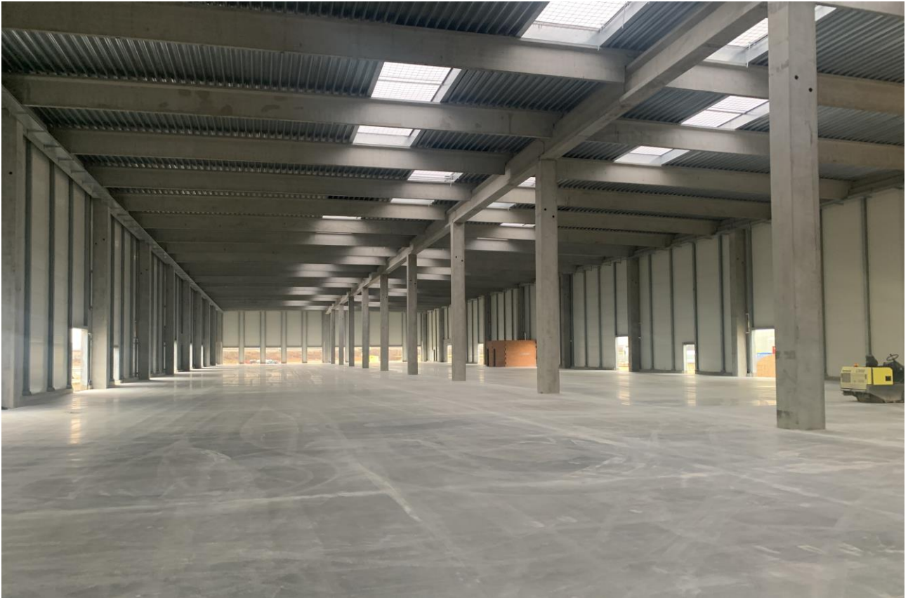
Figura 7. Vista della pavimentazione ultimata
