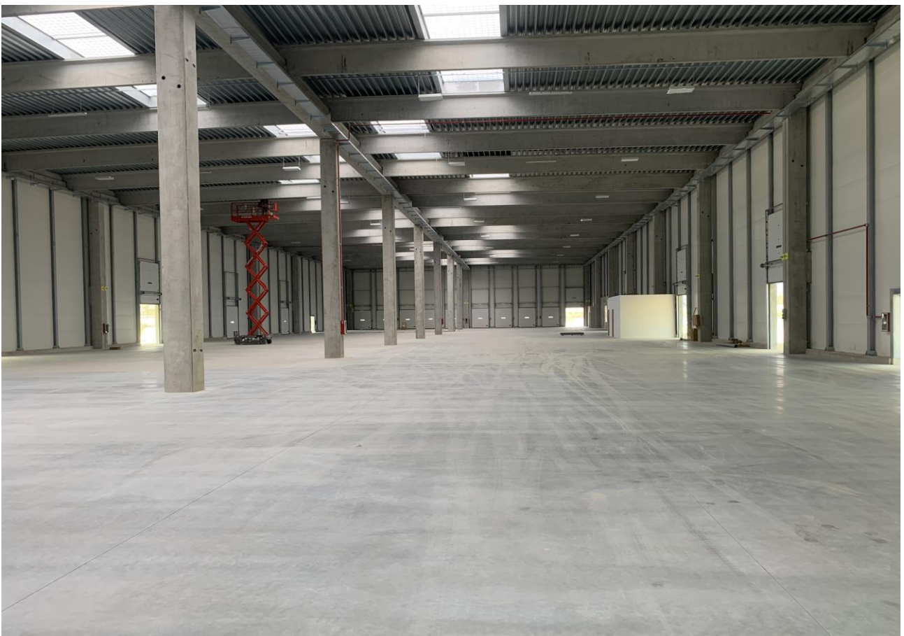
Figura 8. Vista della pavimentazione ultimata
