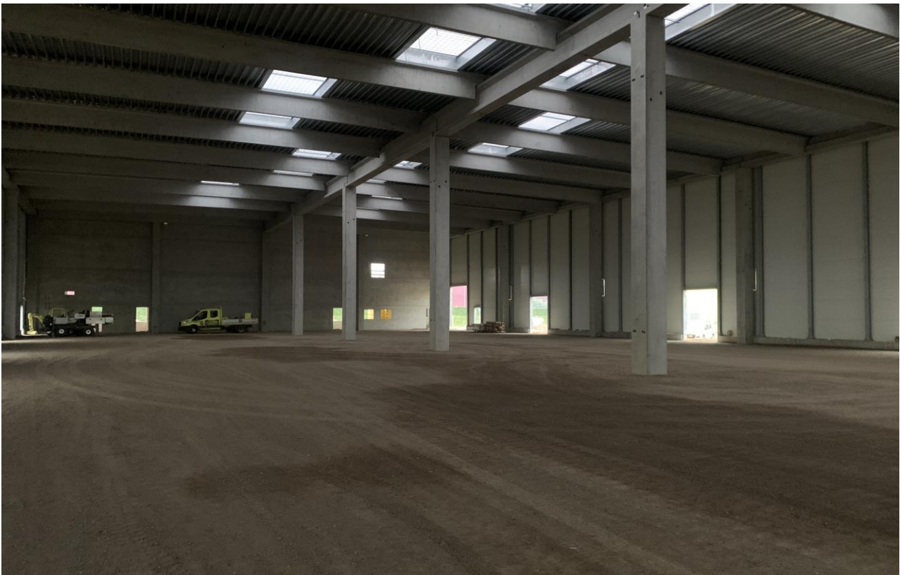
Figura 2. Preparazione del sottofondo della pavimentazione
