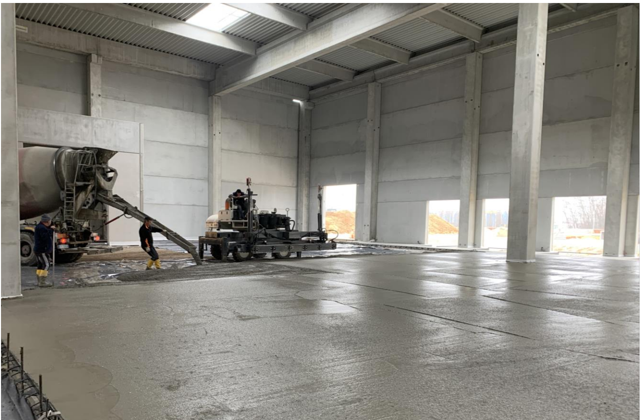
Figura 2. Fasi di getto della pavimentazione fibrorinforzata con FIBRAG® STEEL: F-WG 60/80 SHT
