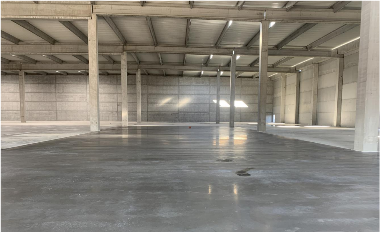
Figura 9. Vista della pavimentazione ultimata
