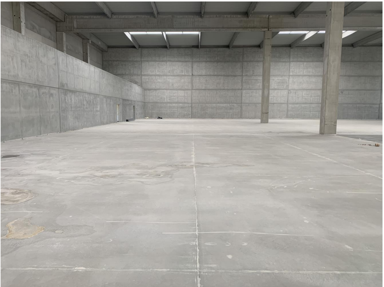
Figura 10. Vista della pavimentazione ultimata
