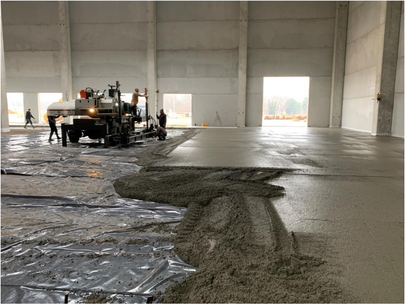
Figura 3. Fasi di getto della pavimentazione fibrorinforzata con FIBRAG® STEEL: F-WG 60/80 SHT
