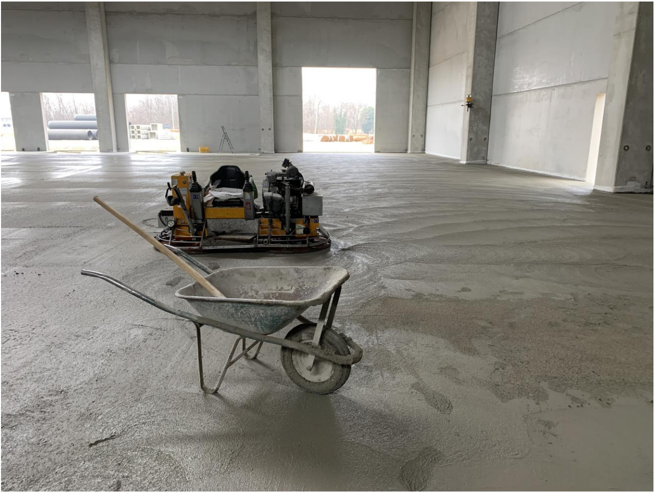
Figura 5. Fasi di stesura della pavimentazione fibrorinforzata con FIBRAG® STEEL: F-WG 60/80 SHT
