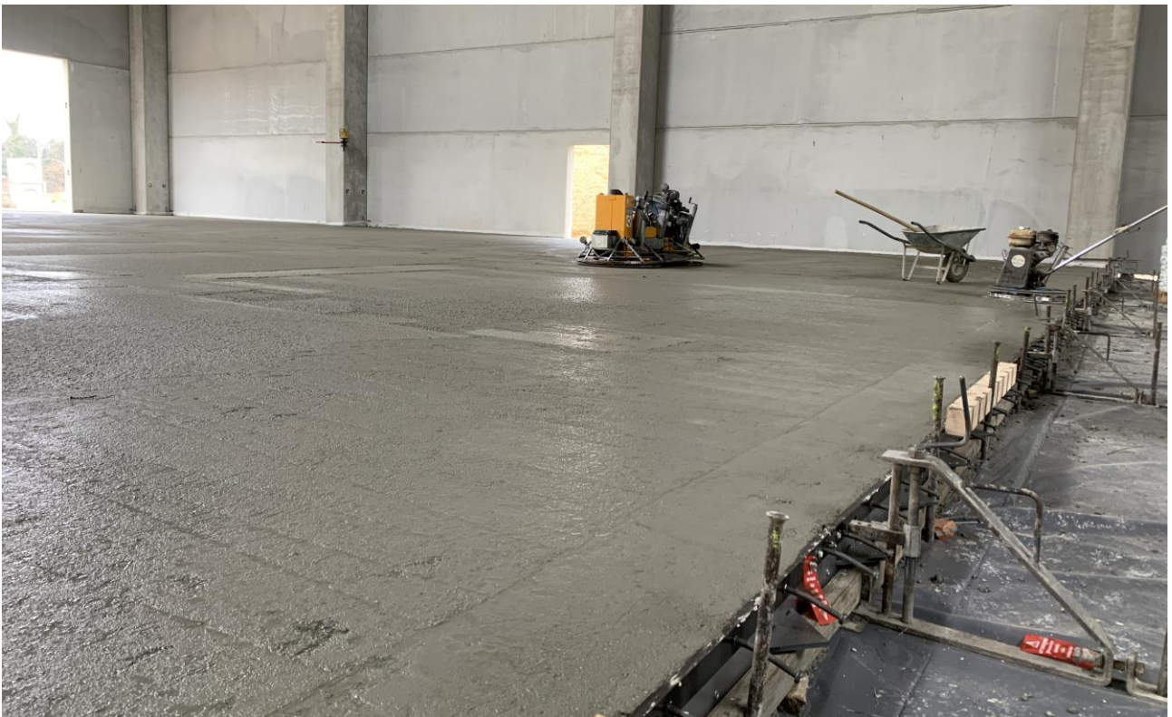
Figura 4. Fasi di getto e stesura della pavimentazione fibrorinforzata con FIBRAG® STEEL: F-WG 60/80 SHT
