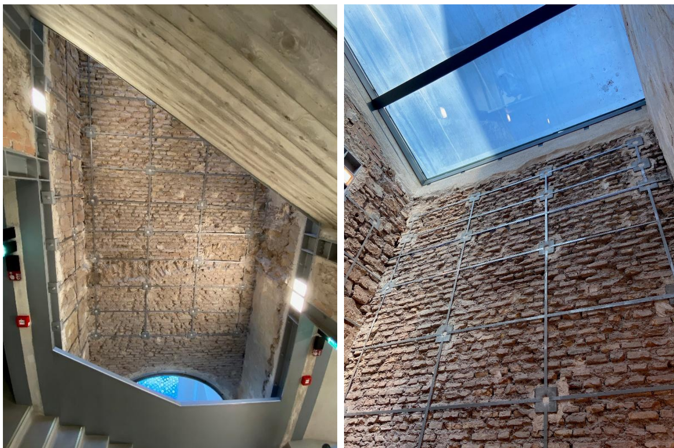
FIGURA 3: LA RIPETIZIONE DEGLI ANELLI DI NASTRO DEL SISTEMA CAM ® SULLE MURATURE
