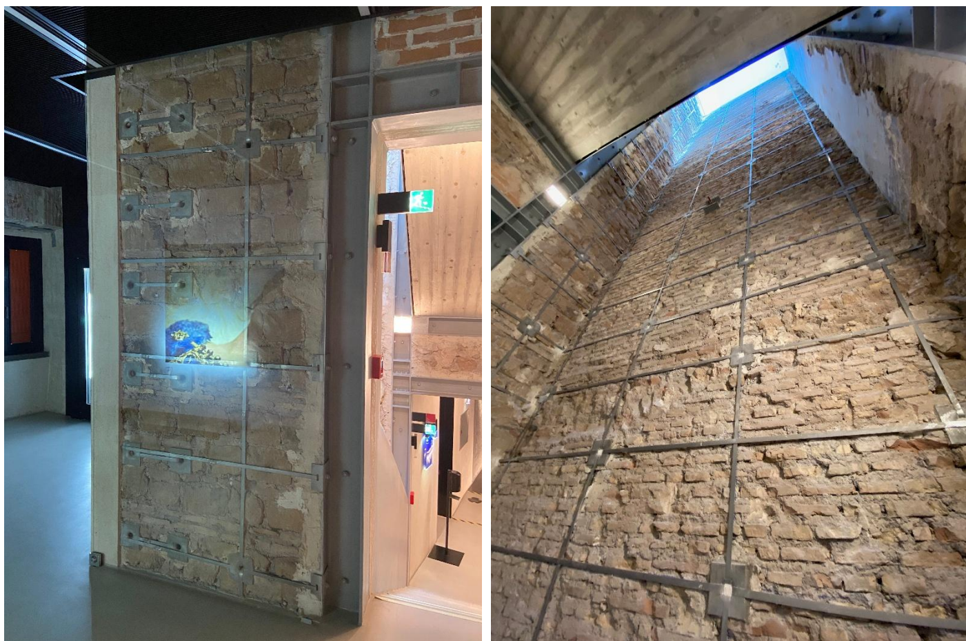
FIGURA 4: L'INTERVENTO CON IL SISTEMA CAM® LASCIATO A VISTA COME PARTE INTEGRANTE DEL PROGETTO ARCHITETTONICO
