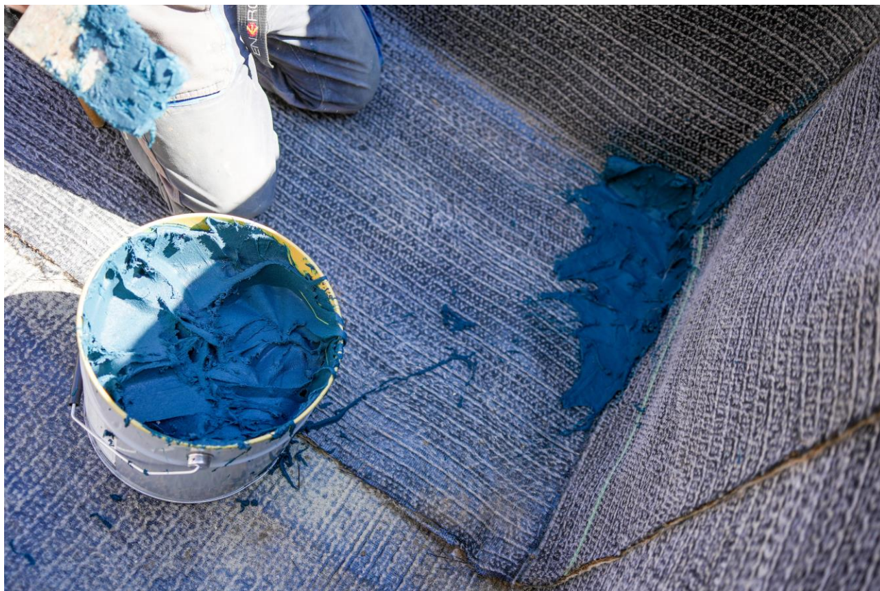
Applicazione del mastice BENTOSEAL, in corrispondenza di teli bentonitici.
