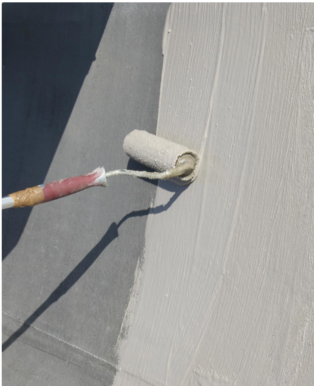
Applicazione a rullo di MAGIFLEX BRAVO.
