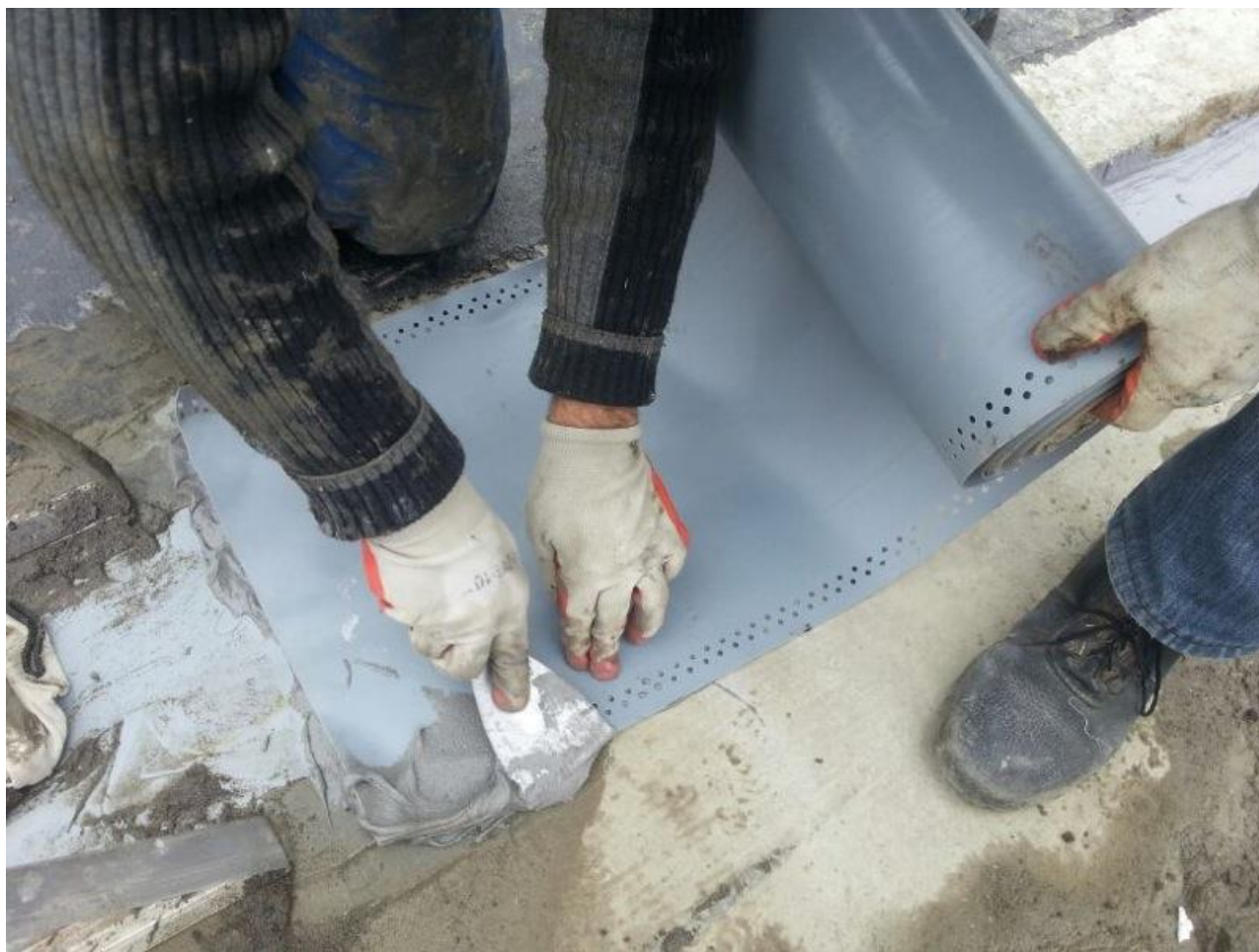
Nastro in TPE FLEXIJOINT incollato con adesivo epossidico EP FIX HP.
