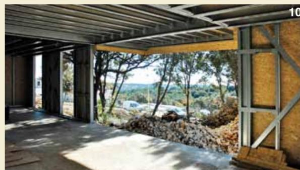
Figura 9 - 10 – Maison B - Struttura in acciaio dall'esterno e dall'interno
