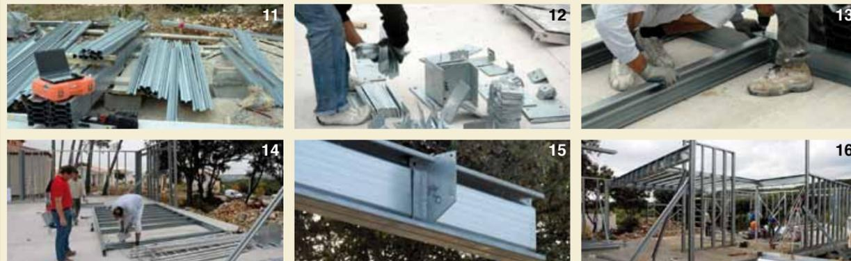
Figura 11 - 16 – Maison B - Montaggio della struttura in acciaio
