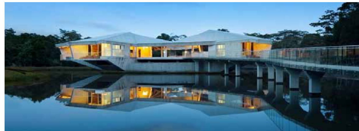
Stamp House, Far North Queensland, Australia, Charles Wright Architects. Vista generale dell'intervento dalla passerella di ingresso. Il Resort realizzato in calcestruzzo è un esempio di architettura energeticamente sostenibile e classificata come rifugio anti-ciclone classe 5
