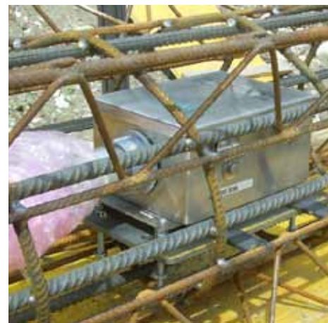
Figura 3. Disegni costruttivi (a) e prototipo di modulo embedded durante l'assemblaggio in cantiere (b).
