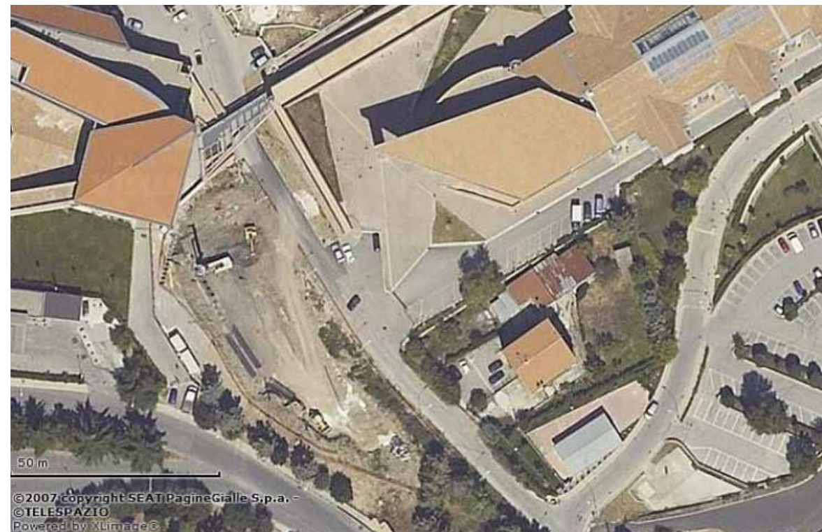
Figura 1. Foto aerea dell'area di intervento in fase di esecuzione dei lavori.
