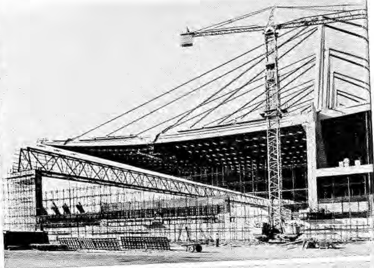
33 - Il modello delle aviorimesse Alitalia per l'aeroporto di Fiumicino; 34-35 - Particolare delle sciabole della copertura e dei relativi tiranti; 36 - Vista laterale di una delle due aviorimesse; 37 - Aviorimesse Alitalia per Boeing 747 per l'aeroporto di Fiumicino: sezione longitudinale.
