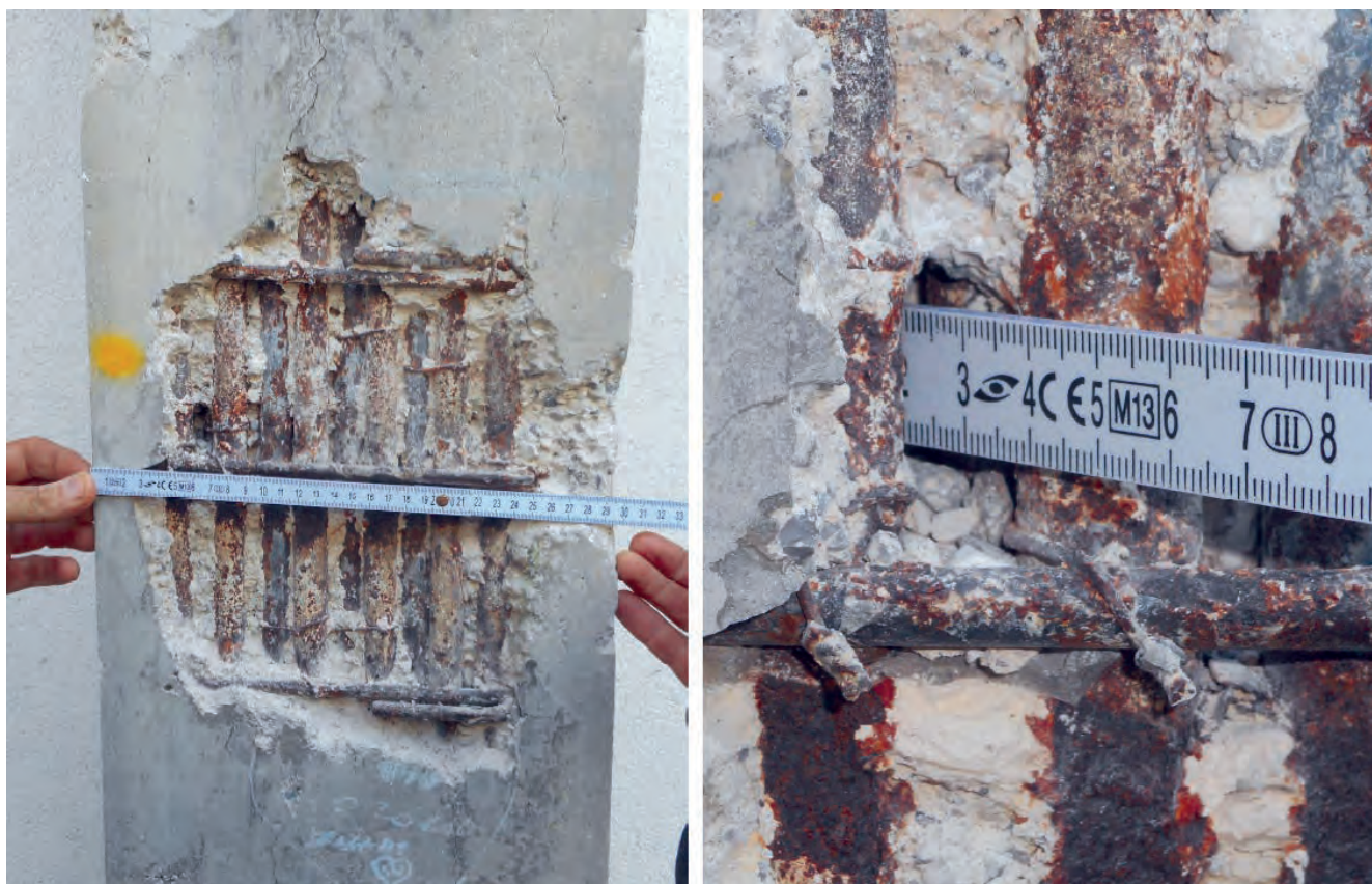
Figura 4 ▲ Foto delle indagini eseguite sulle strutture.
