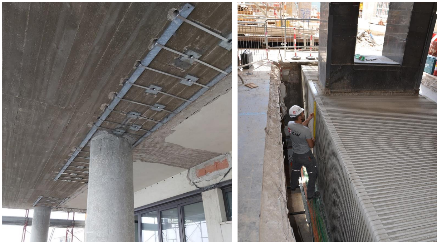
FIGURA 4 CANTIERI EDIL CAM SISTEMI – INTERVENTI SU TRAVI A SPESSORE O DI DIMENSIONE RILEVANTE
