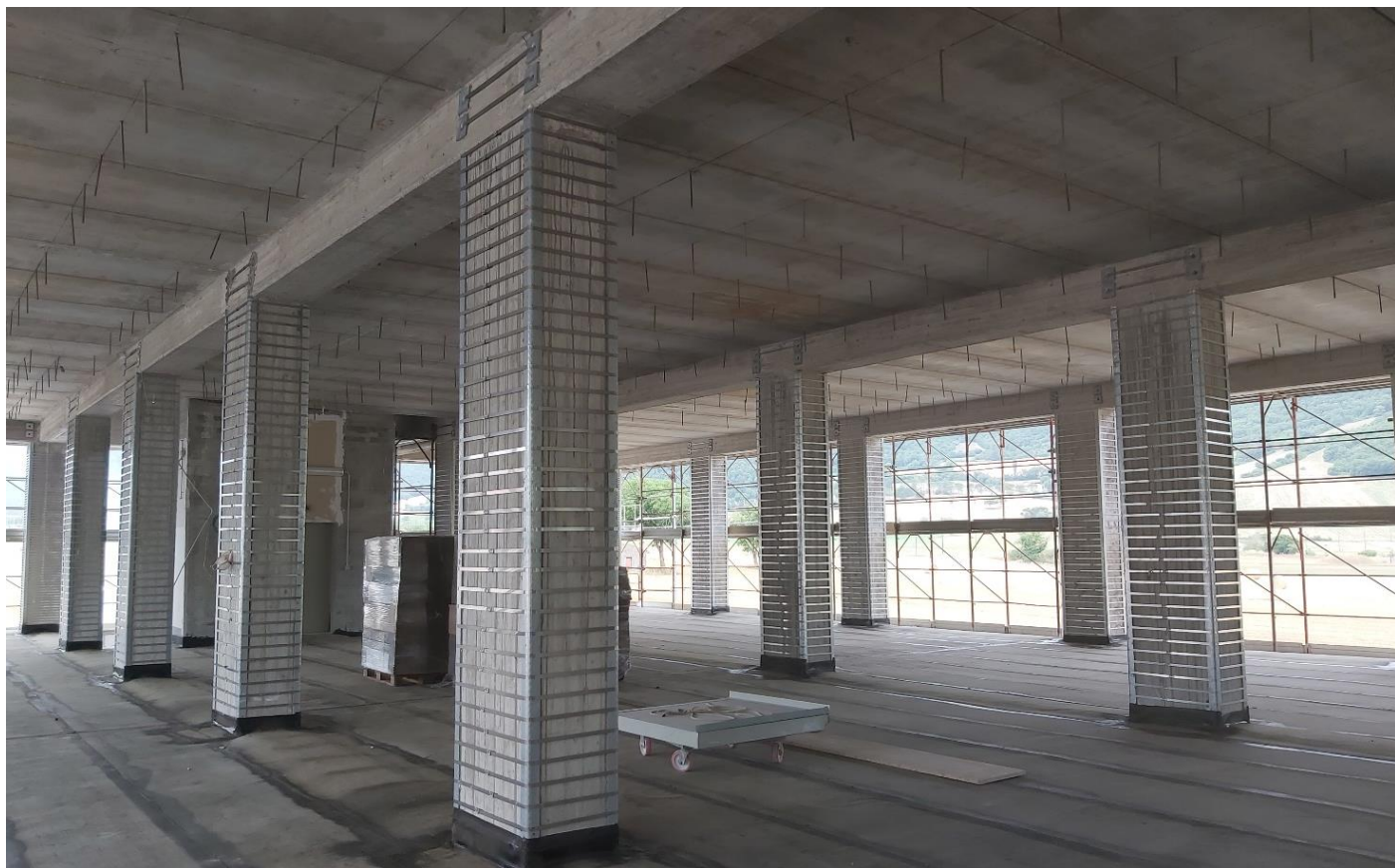
FIGURA 5 CANTIERI EDIL CAM SISTEMI – IL CONFINAMENTO ATTIVO DEI NODI TRAVE-PILASTRO
