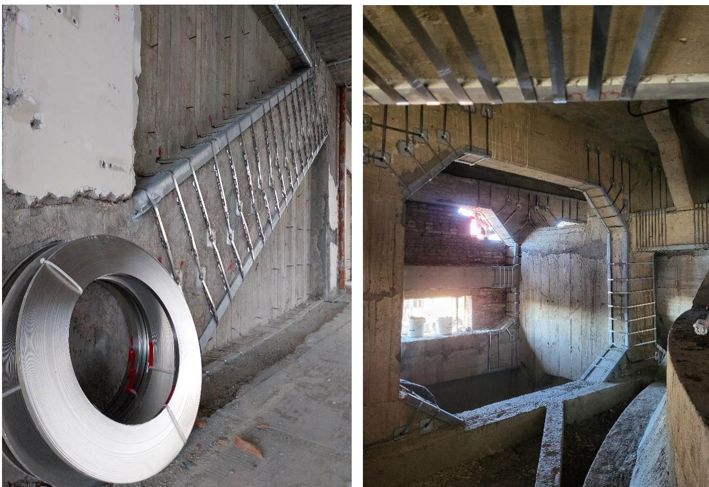
FIGURA 1 CANTIERI EDIL CAM SISTEMI – SERVIZI GENERALI DE “LA SAPIENZA” E TAMBURO DELLA CUPOLA DEL “CRISTO RE” – PROGETTI ORIGINARI DEL PIACENTINI
