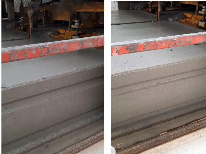
Figura 2 – Sulla sinistra, l'elemento prodotto con il mix di riferimento (400 kg/m 3 di cemento); sulla destra l'elemento prodotto con mix a ridotto contenuto di clinker (350 kg/m 3 di cemento) e Master X-Seed STE 35.
