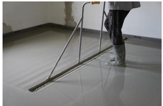
I supporti livellati con Planitex S e Planitex L sono idonei a ricevere pavimentazioni in ceramica, pietre naturali, resilienti, parquet prefinito e pavimentazioni sopraelevate.
